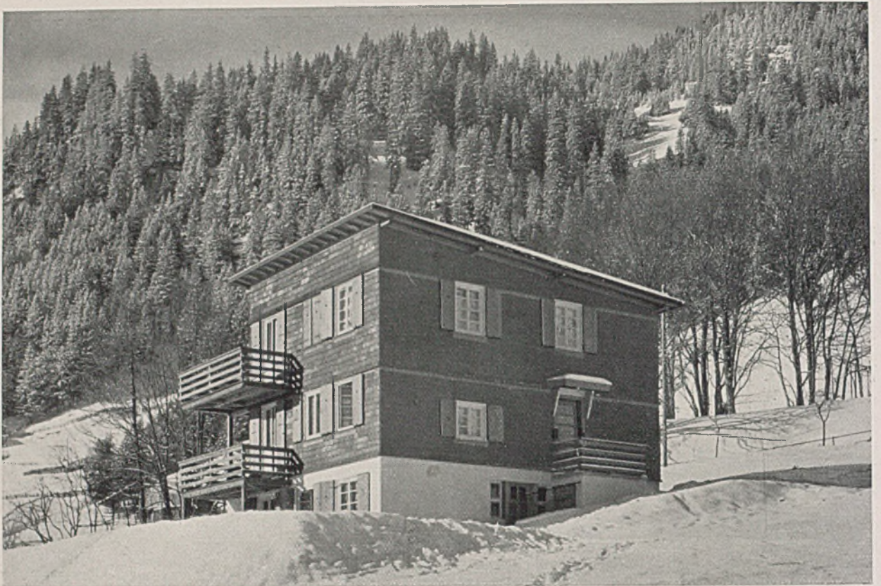
Holz-Berghaus in Adelboden. Südost-Ansicht im Winter
