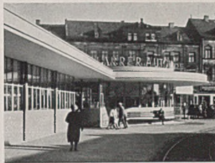
Westseite, Blick von Norden, entlang der Wartehalle, auf die Imbißhalle
