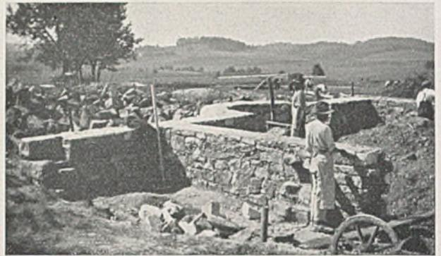
*Fundamente (Granitbruchstein-Mauerwerk, in den Lücken Betonklötze für die Binderständer)*
