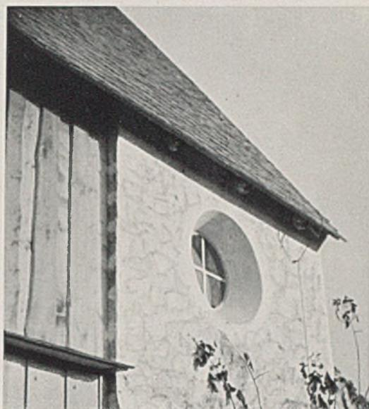
Seitlicher Anschluß von Holzwand und Bruchsteinmauerwerk
