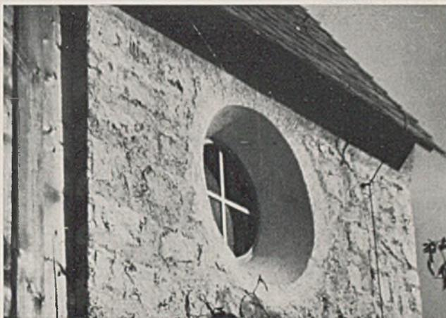
*Außenputz*, Detail. Die Fugen des Bruchsteinblossenmauerwerkes sind mit Putzmörtel beworfen und abgezogen; die Backsteinleibungen sind glatt verputzt (Sikamörtel), desgleichen das aus Backstein vorgemauerte Gesimse. Die Außenfläche ist mit dünner Kalkweiße leicht aufgehellt. Sonst: Schindeldach, überlückte baumkantige Schalung.
