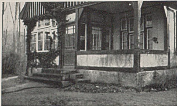
Der alte Zustand des Hauses
