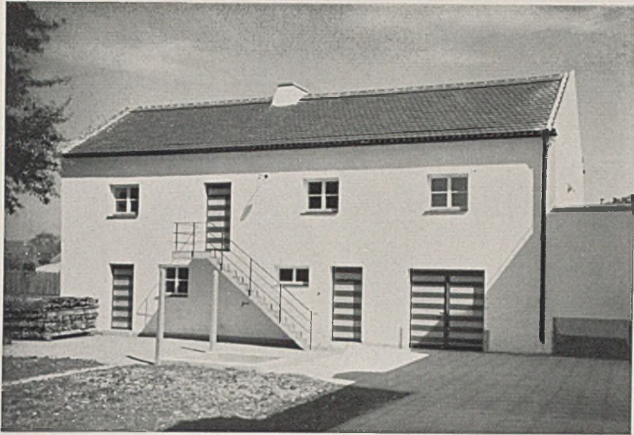
Nebengebäude zum Postamt in Moosburg (siehe Tafel 56)
