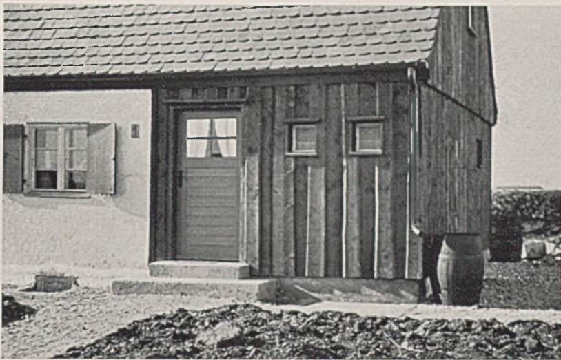
Einzelheiten der Außengestaltung des Stall- und Schuppenteiles, der als Wohnraum ausbaufähig ist
