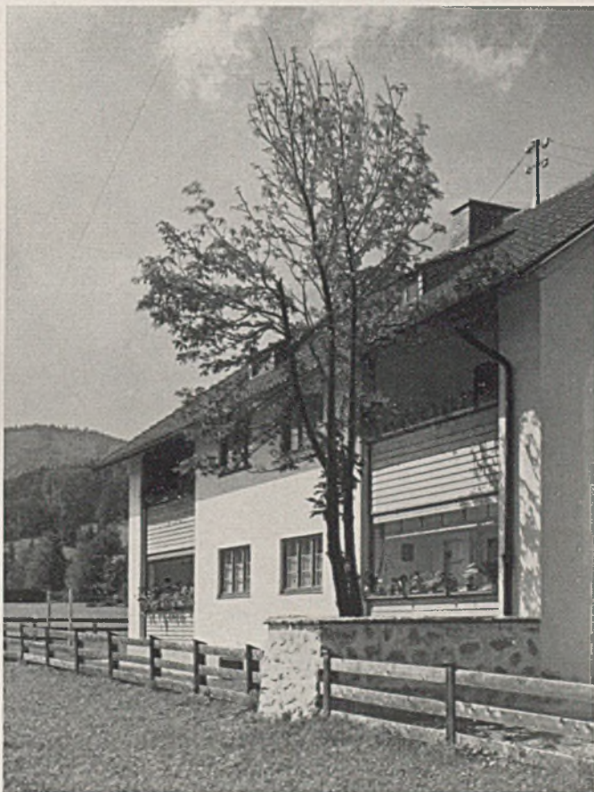
Postwohngebäude in Bad Wiessee (siehe Tafel 57)
