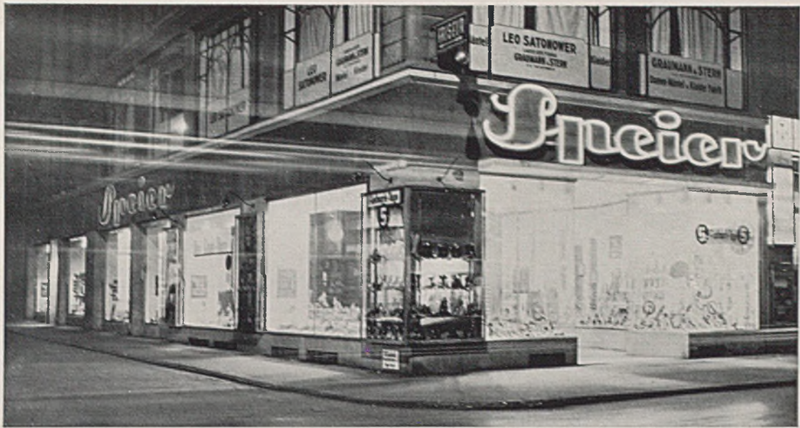
Schaufensteranlage im Ladenvorraum „Speier“ in der Kaufingerstraße, München (siehe Tafel 52) Architekt Kurt Pick, Frankfurt a. M.
