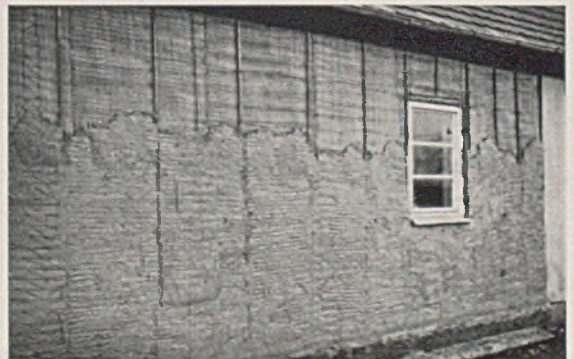
Herstellung des Putzes auf Drahtgestlecht über Holzschalung und Papperkleidung. (Einzelheiten der Holzkonstruktion auf den Tafeln.)
