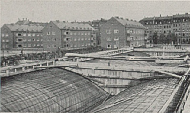
Eisenbeton-Schalengewölbe-Konstruktion über den Kraftwagen-Einstellhallen, Nürnberg
