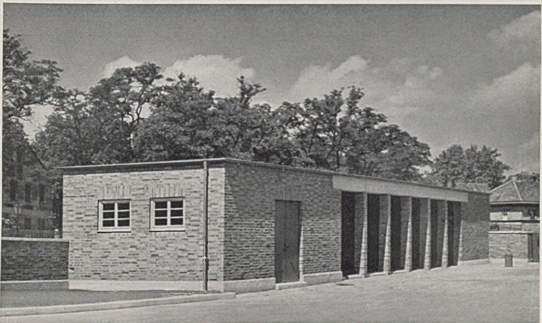
Kraftpostwerkstättegebäude Nürnberg. Lagerhalle an der Ausfahrt im Westhof
