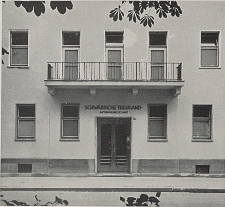
Blick auf den Eingang nach dem Umbau (Photo Moegle - Stuttgart)
