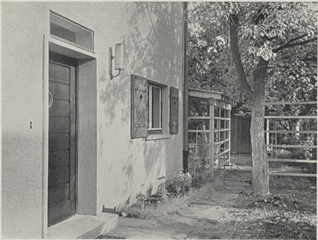
Blick vom Eingang nach der Laube
