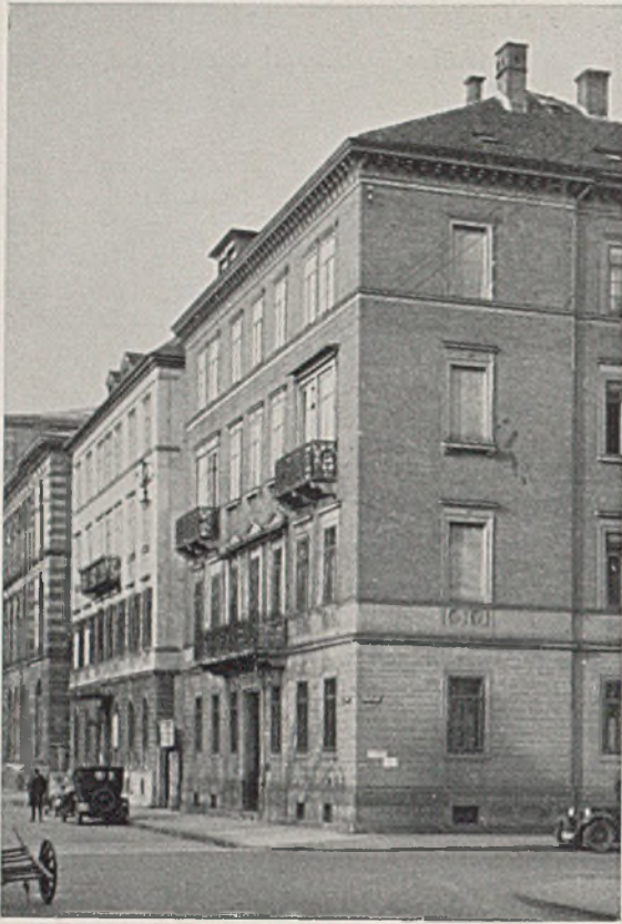
Haus vor dem Umbau
