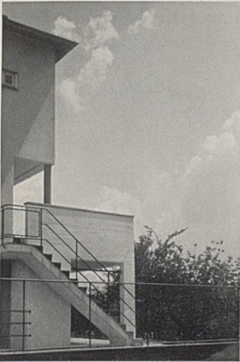
Terrasse und Treppe zum Garten
