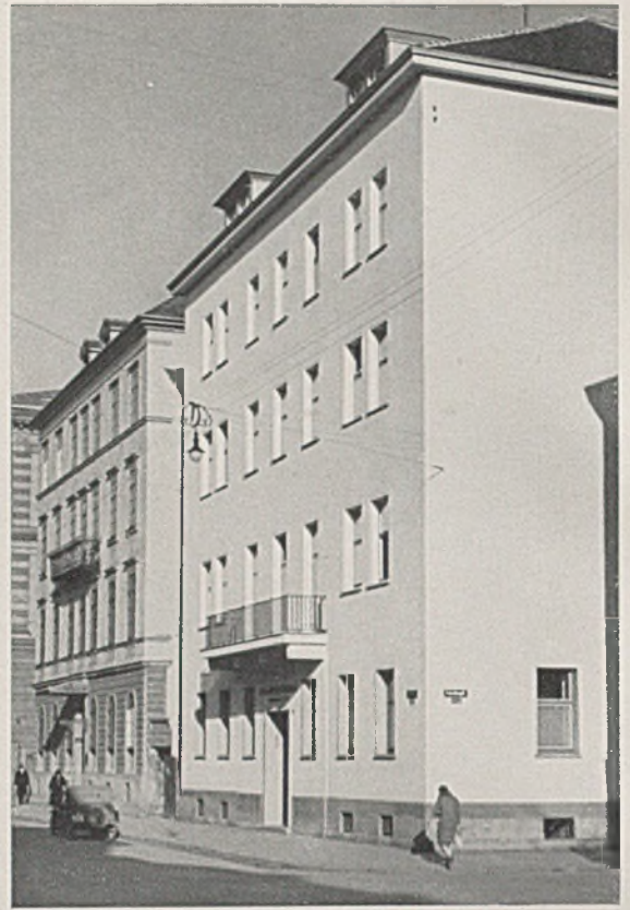
Haus nach dem Umbau
