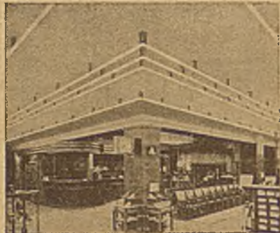
Linja świetlna, wykonana z Osramówek-Linestra, uwydatnia kontury pomieszczenia i daje mu bogate, równomiernie rozłożone dekoracyjne oświetlenie.
