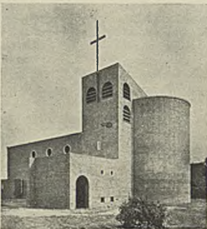
Arch.: C. G. Benseł, J. Kamps i H. Amsinck. Kościół św. Pawła w Altonie. (Monatshefte für Baukunst).
