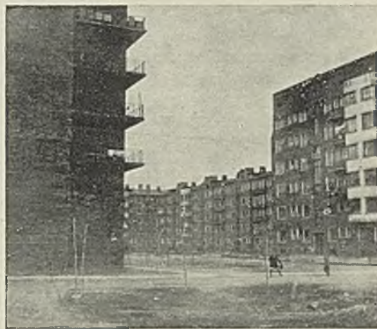
11—12. Olbrzymi dom, t. zw. „Ameryka“ na Dangauerówce, również zw. „sow. central“. Kofłownia posiada 3 kominy, każdy 1 m 2 w przekroju. Budowa rozpoczęta i niedokończona, następnie kontynuowana przez bud. amerykańskich.
