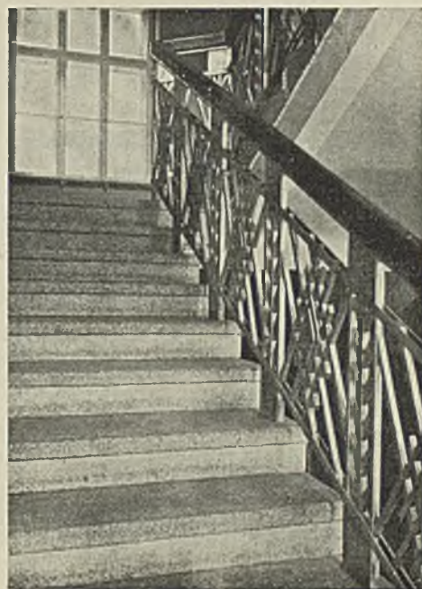
Szczegół bocznej klatki schodowej
