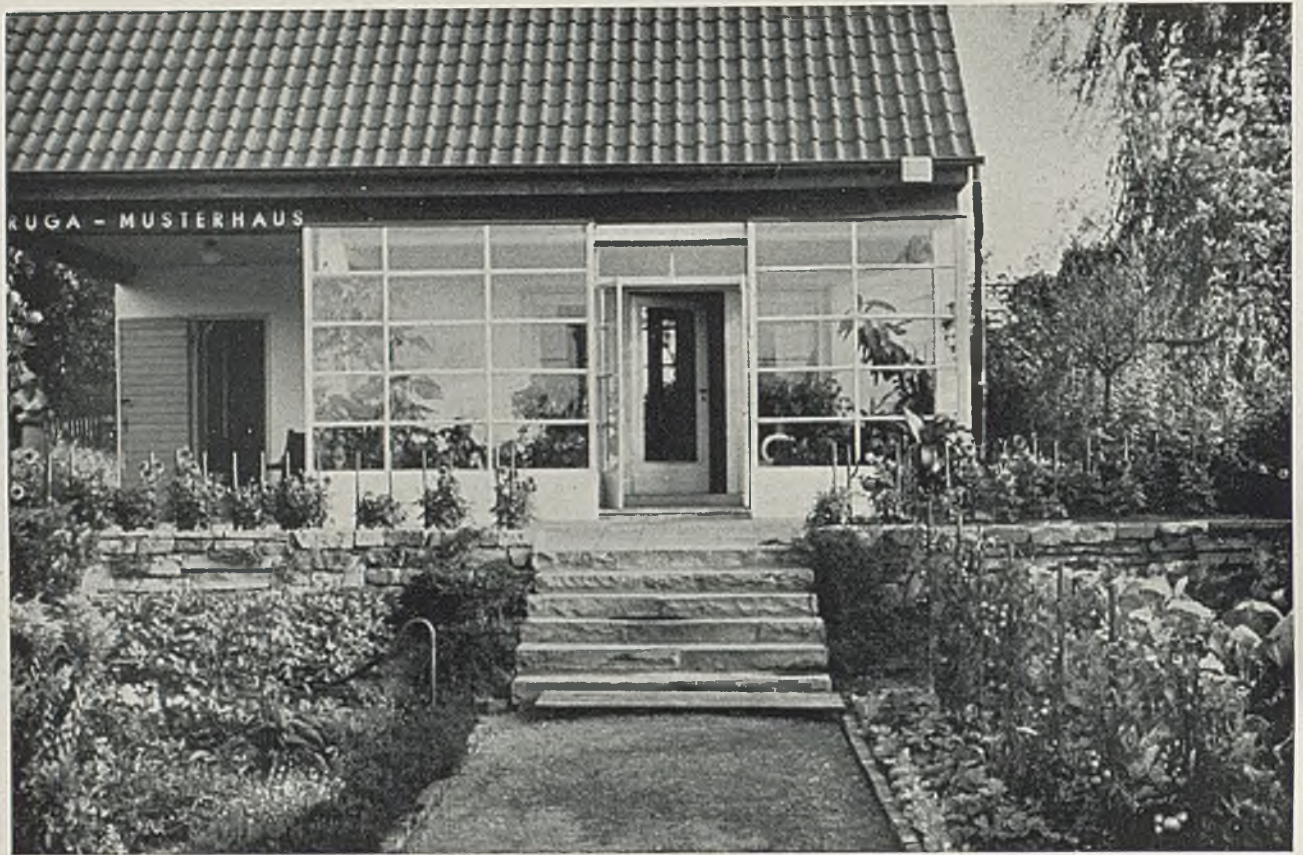
Kleinhaus mit Wintergarten, „Gruga“ Essen. Architekt Prof. Dr.-Ing. Alfred Fischer und Architekt Spitmann, Essen
