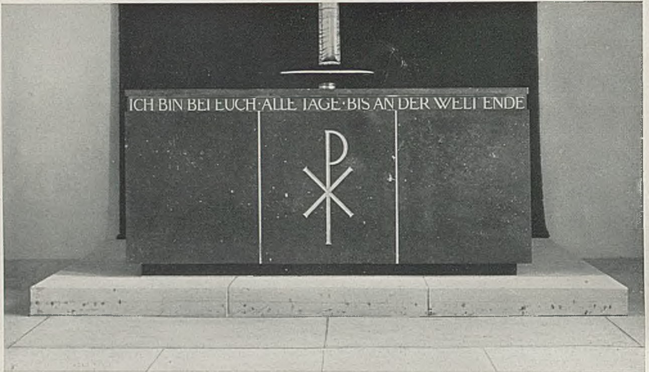
Kirchenumbau Obfelden. Oben Altar in schwarzem geschliffenen Kalkstein, darauf das Taufbecken frei hingestellt als flache silberne Schale. Unten: Chor, alter Zustand; rechts unten: neue Kanzel in ungestrichener Berglärche. Mauerflächen in stark gebrochenem Weiß, Bodenbelag in lichtroten Klinkern und hellgrauen Sandsteinplatten. Eiserne Fensterrahmen lichtrot, Verglasung hell-graugrün
