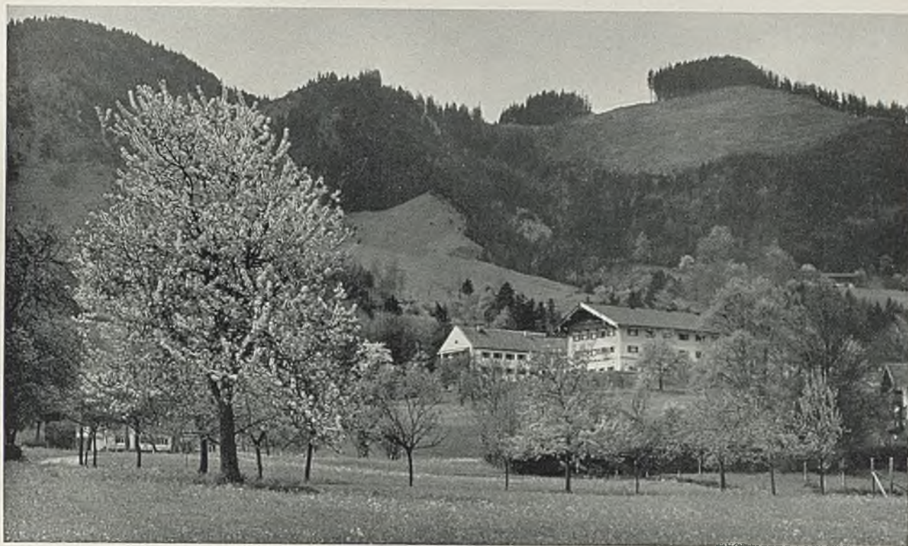
Erholungsheim Brannenburg; links Bauteil 2 (1930), rechts Bauteil 1 (1924-25)
