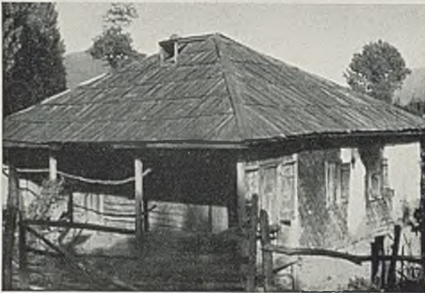
Verandahaus im Kodortal Fachwerk mit Latten und Steinchen als Ausföchung
