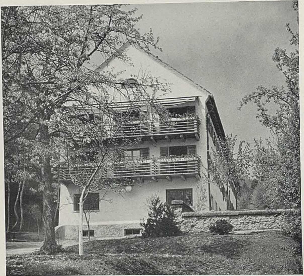
Erholungsheim Brannenburg, Bauteil 2, 1929-30. Südost-Ansicht mit Zugangsweg zum Heim
