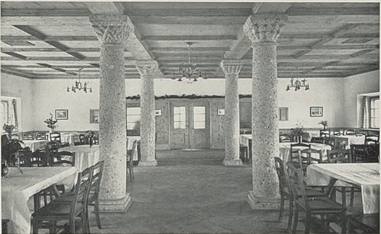
Erholungsheim Brannenburg, Bauteil 1, 1924-25. Speisesaal Boden Eichenschrägriemen, Decke und Einrichtungsgegenstände in Zirbelholz, Säulen in Nagelfluh
