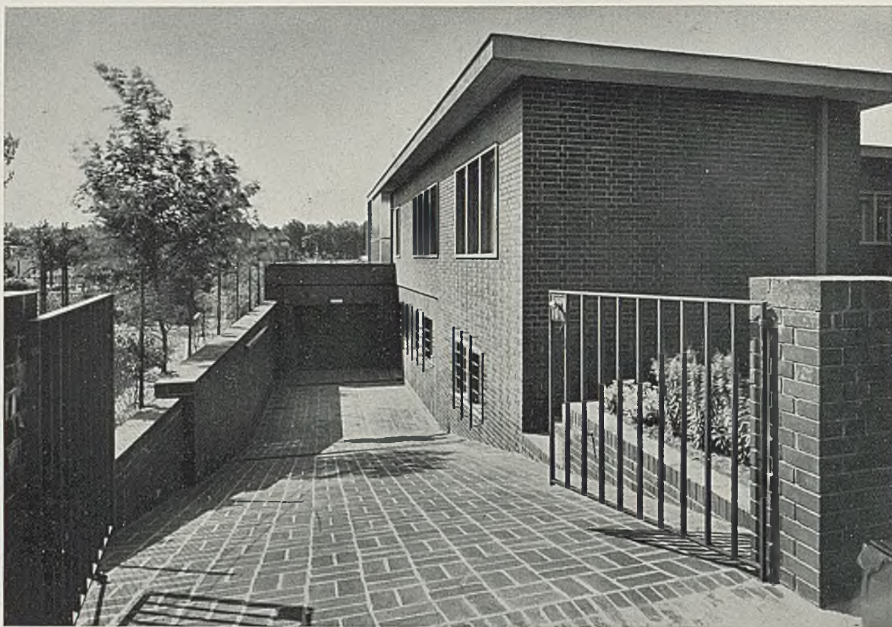
Wohnhaus K. R., Berlin. Die Autoeinfahrt mit vertiefter Garage (Hiezu Tafel 49-53)
