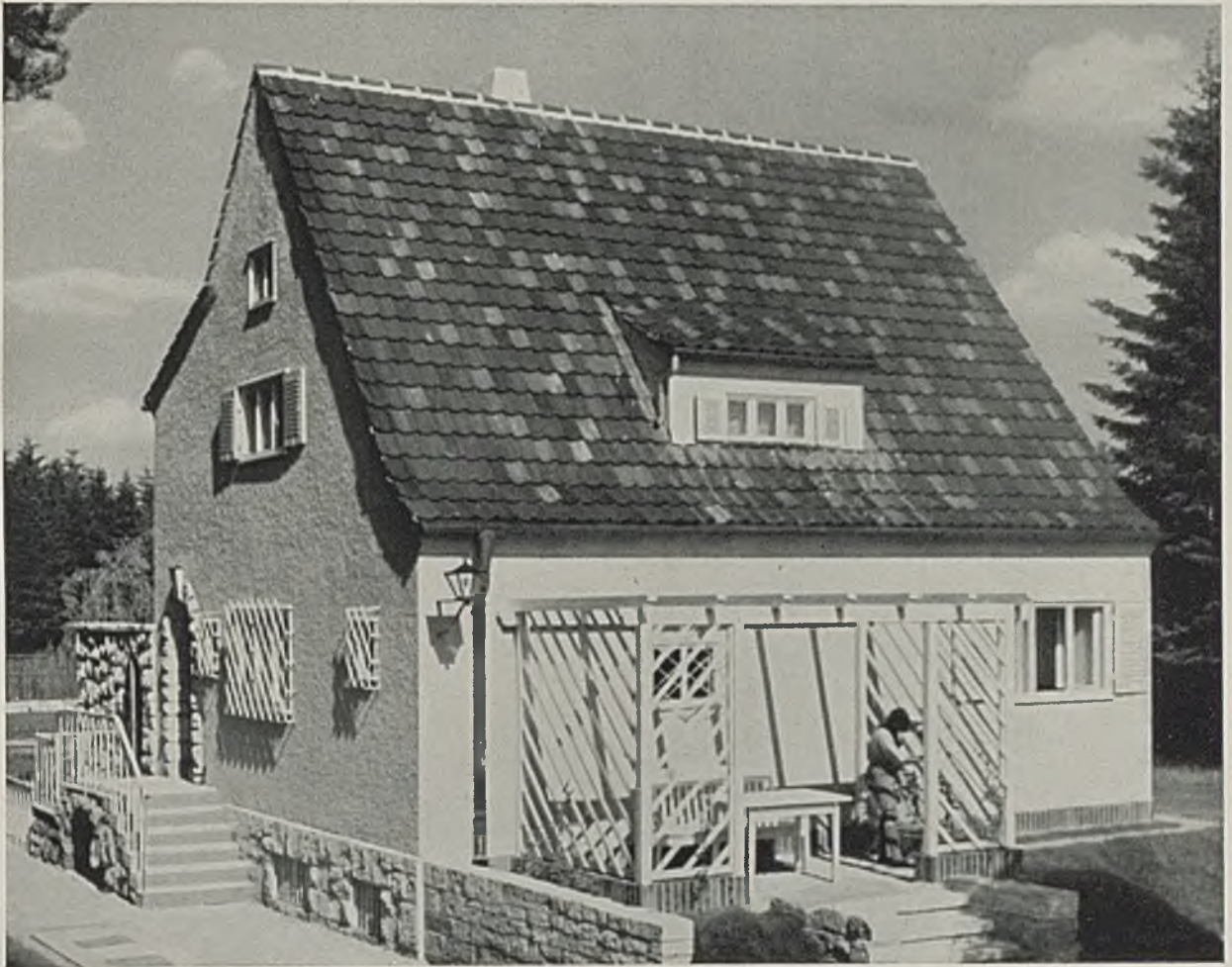
Haus R. in Ottobrunn bei München (1933–34). Architekt Reg.-Baumeister H. Strobel
