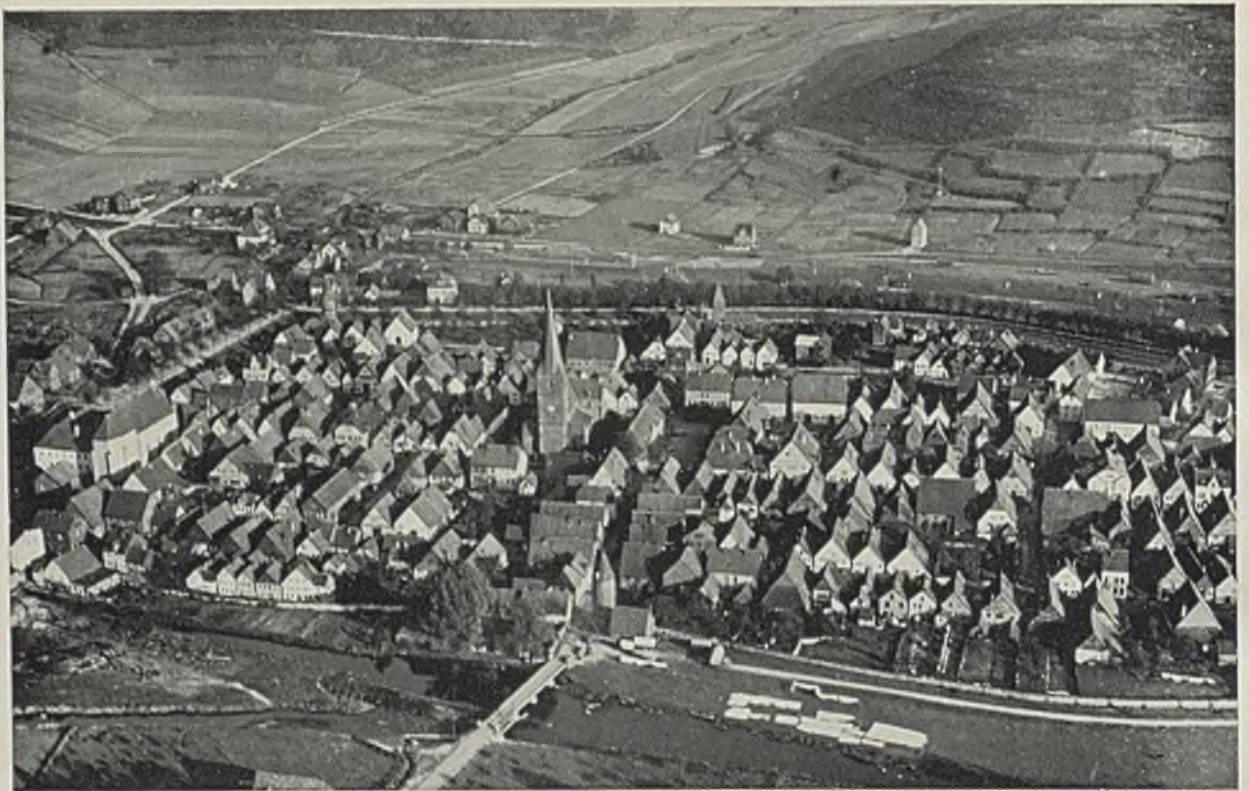
Lügde, Kreis Höxter, Westfalen*. Gegründet im 12. Jahrhundert. Castrumgrundriß. Unten Lageplan i. M. 1:5000
