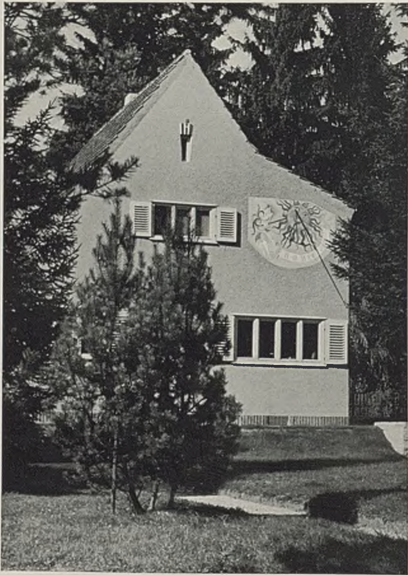
Wohnhaus R. in Ottobrunn bei München, Gartenseite
