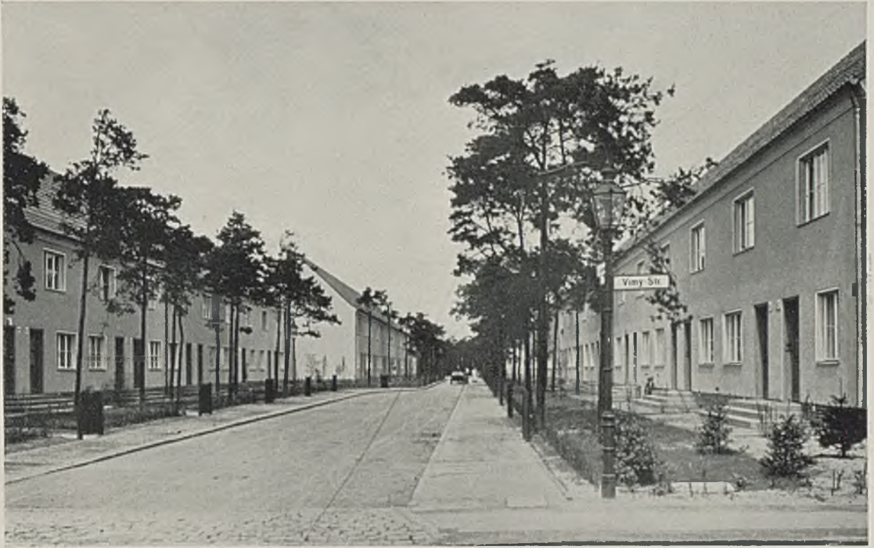
Siedlung Adlershof, Berlin. Argonnenstraße
