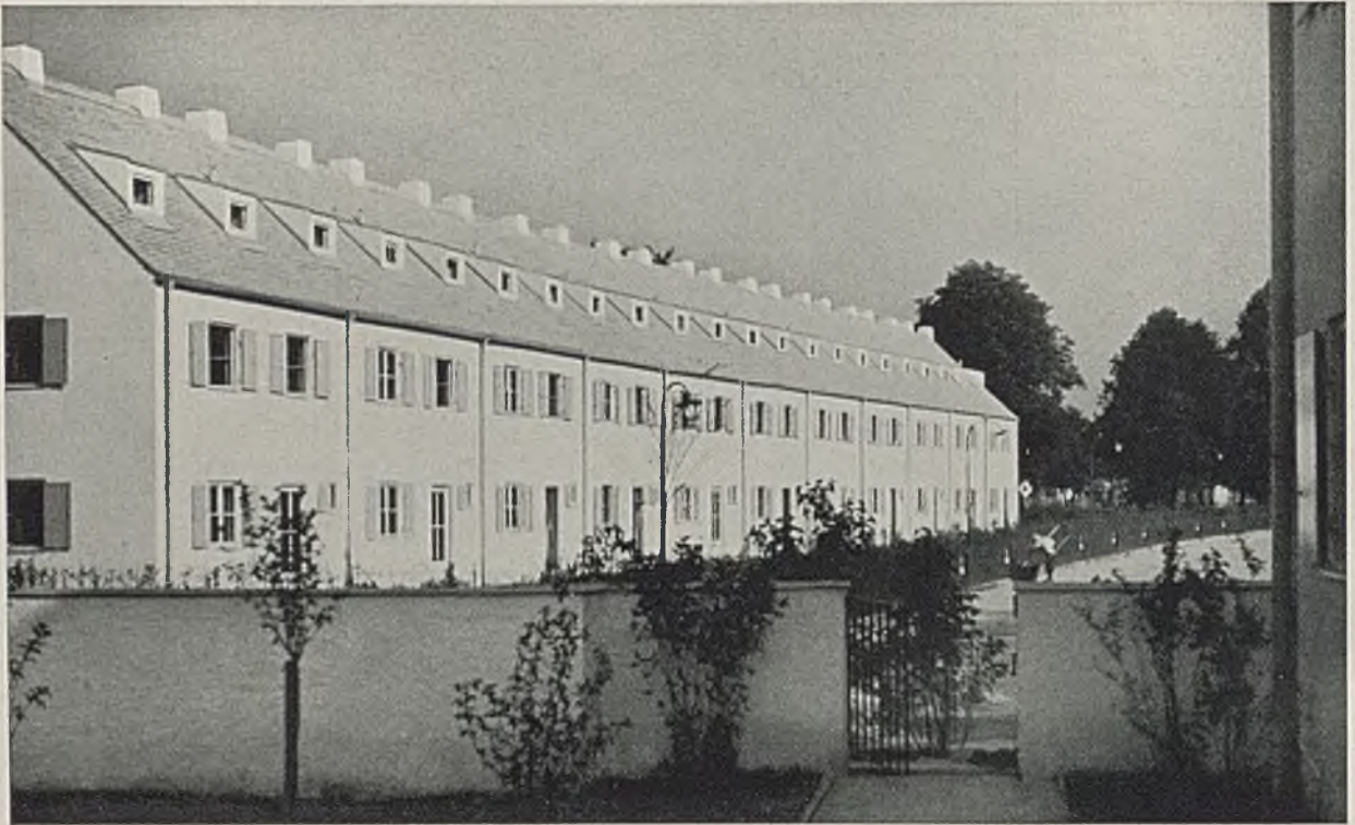
Reihenhäuser Typ R II an der Ehrlichstraße, von Süden gesehen. Architekt Regierungsbaumeister Guido Harbers
