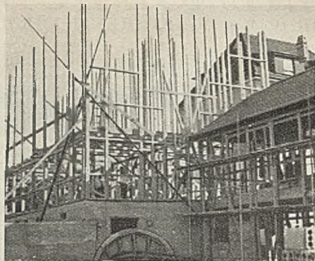
Haus 4 (Bonatz und Scholer) Bauweise in Ständerfachwerk (System Epple)
