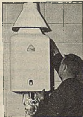
Abb. 1. Abnahme des äußeren, porzellanemailierten Ziermantels nach Lösen einer einzigen Schraube.
