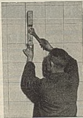
Abb. 5. Mit der einfachen Anbringung des Aufhängehakens hat die Installation begonnen.
