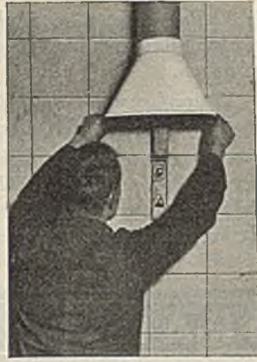
Abb. 4. Abzugshaube mit Rohr braucht nicht abgenommen zu werden.
