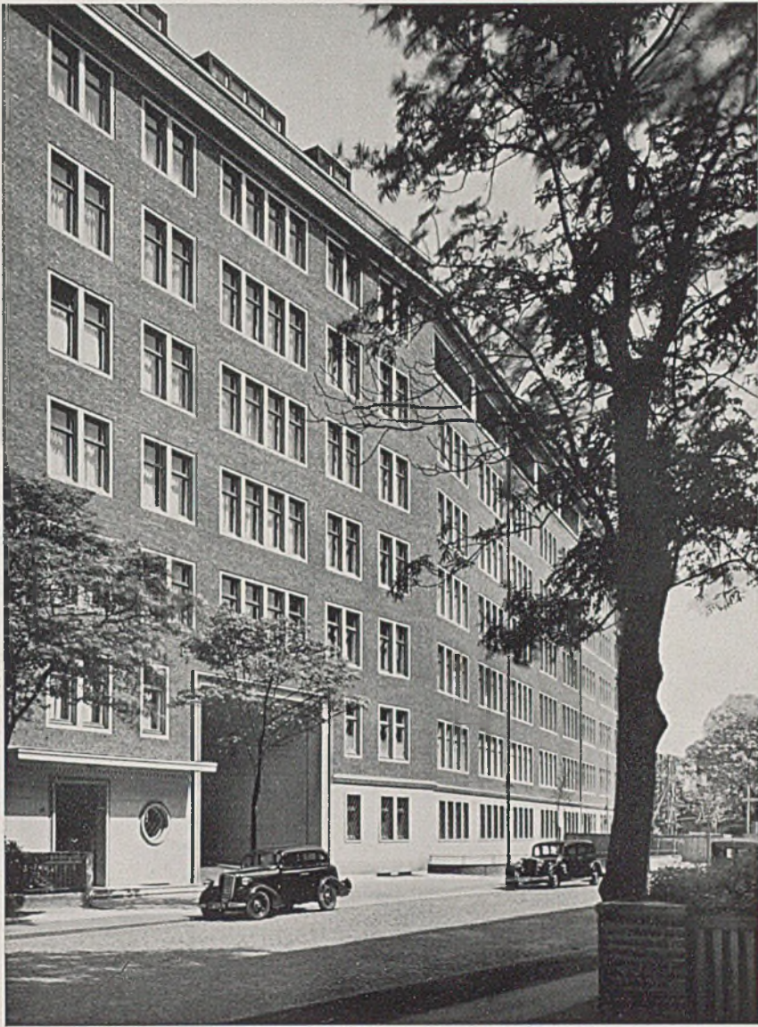
Das Verwaltungsgebäude der P. Beiersdorf & Co. A.-G., Hamburg 1937
