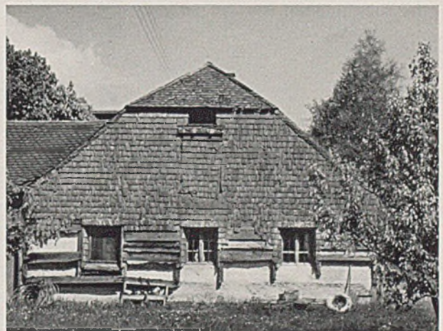
Altes Vorbild für den Wetterschutz: links altes Fischerhaus in Seebruck am Chiemsee mit stark zerstörter Schindelverkleidung infolge fehlender Luftlattung, Baujahr 1806; rechts ein weiteres altes Fischerhaus, senkrechte Giebelverschalung
