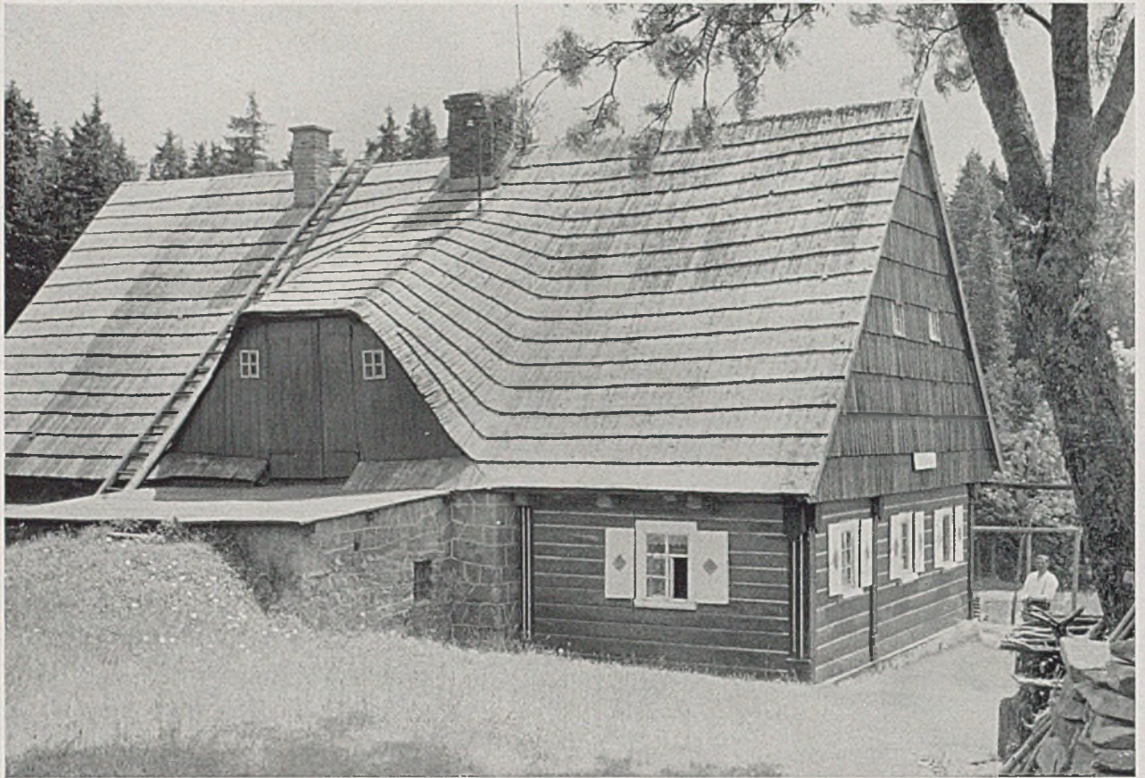
Riesengebirgsbaude in Grenzbauden bei Groß-Aupa. Langschindeldeckung von Giebel, Dachfläche und großer Dachgaube
