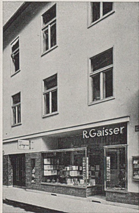
Blick von der Straße auf den Ladenumbau
