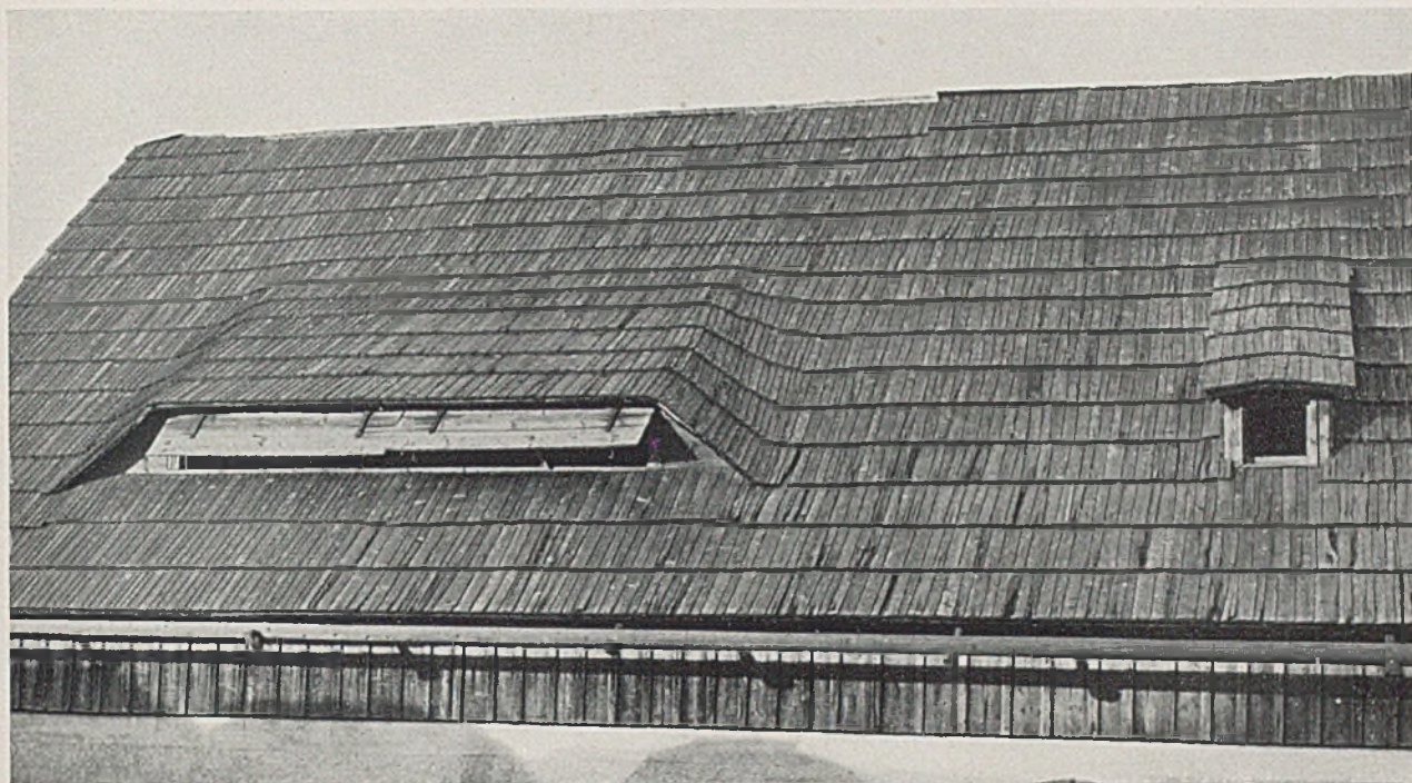
Satteldach mit altschlesischer Langschindeldeckung und verschieden geformten Dachgauben
