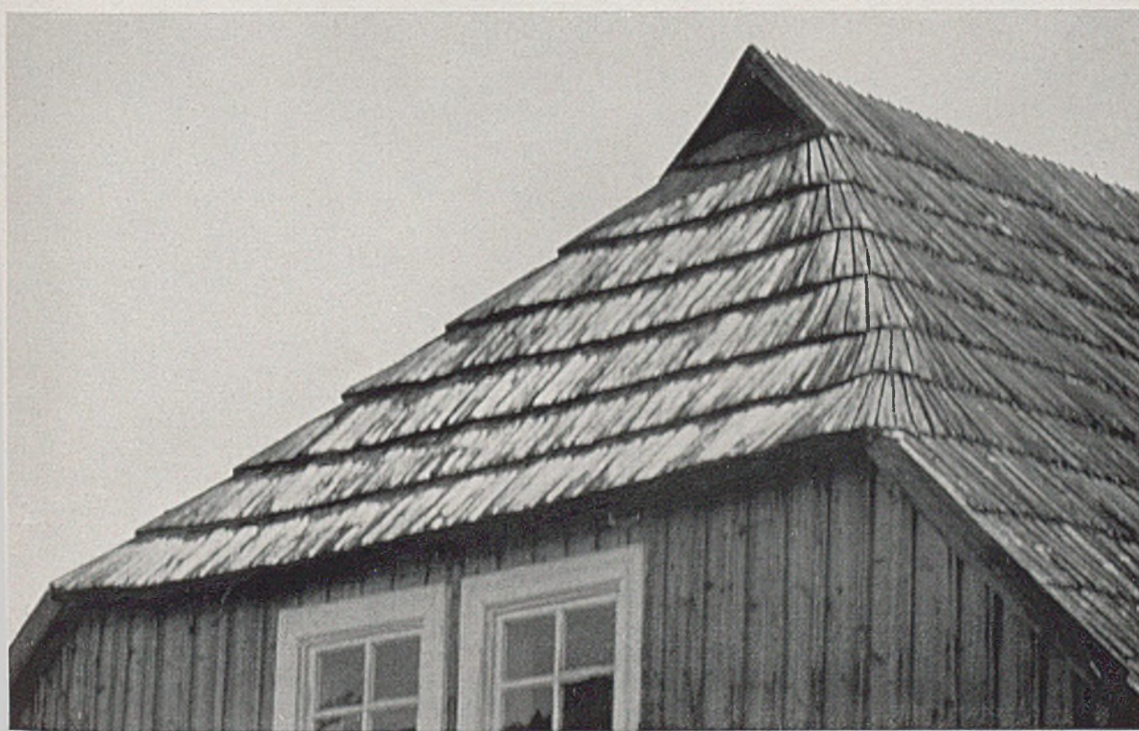
Langschindeldeckung in Schlesien. Eindeckung eines Krüppelwalmes mit abgerund. Graten (Foto Hanson-Hirschberg)
