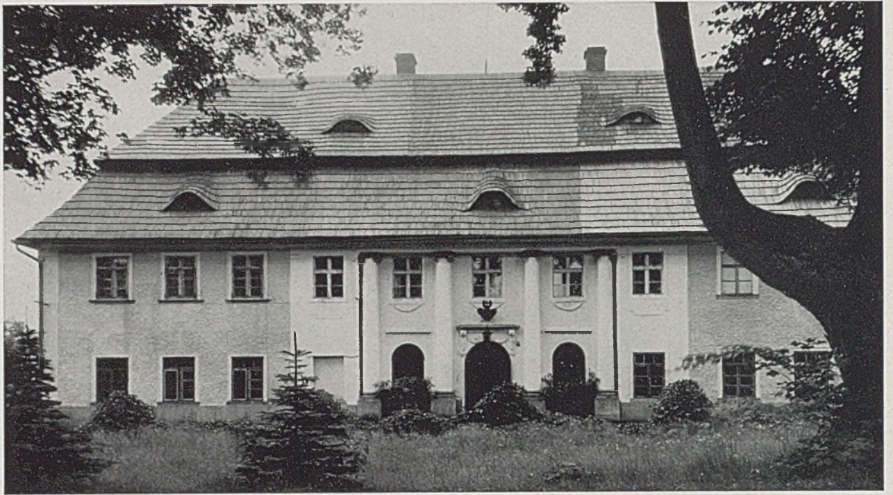
Schloß Schreibendorf, Pr. Landeshut. Dachdeckung mit Langschindeln (Foto Hartson-Hirschberg)
