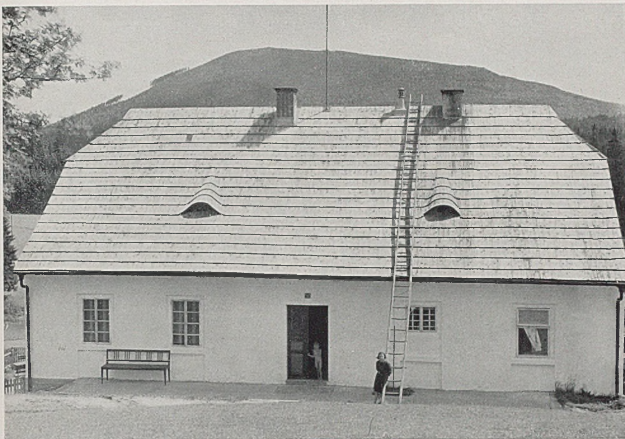
Das neugedeckte Schindeldach hat eine saubere und freundliche Wirkung für Haus und Landschaft
