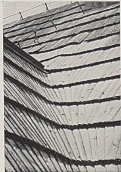
Riesengebirgsbaude, Kehldeckung mit konischen Langschindeln (Fotos Hanson) (Aus „Das Holzhausbuch“ v.G. Harbers, Verlag Georg D.W. Callwey - München)
