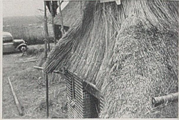
*Arbeitsvorgang bei der Eindeckung der Dachflächen mit Stroh; links ebene Dachfläche, rechts Walmdeckung*
