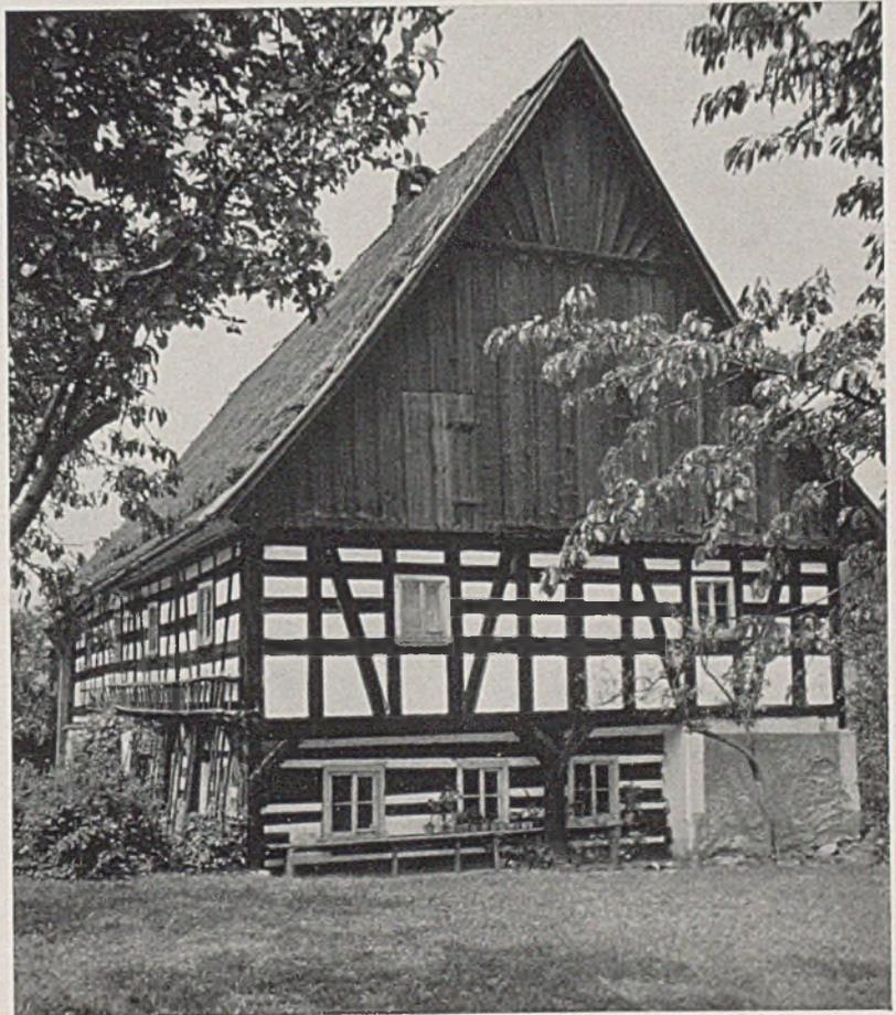
Umgebäudehaus mit Fachwerk im Obergeschoß und mit dünnem Strohdach. — Sockelgeschoß mit Blockwandfüllung weiß verputzt; Obergeschoß in Fachwerk. Die Holzstreben, -säulen, -riegel und -pfetten sind alle dunkel gestrichen und gleich breit. Stark horizontale Betonung durch Anordnung von drei Riegelstreifen in Fensterhöhe; Giebel senkrecht verschalt. Im Giebeldreieck Verzierung durch fächerförmige Anordnung der Schalbretter.
