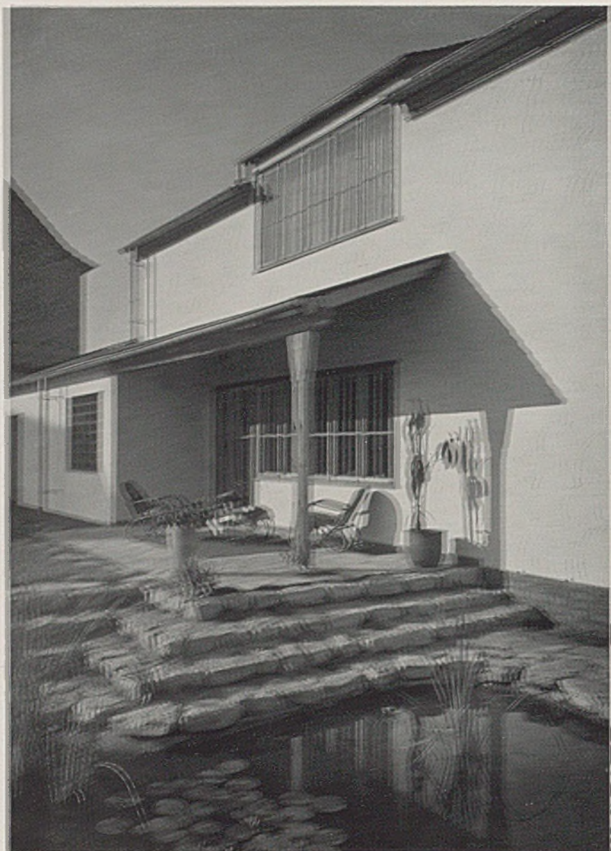
Einflügeliges Wohnhaus K. in Saarbrücken. Blick auf den gedeckten Gartensitzplatz
