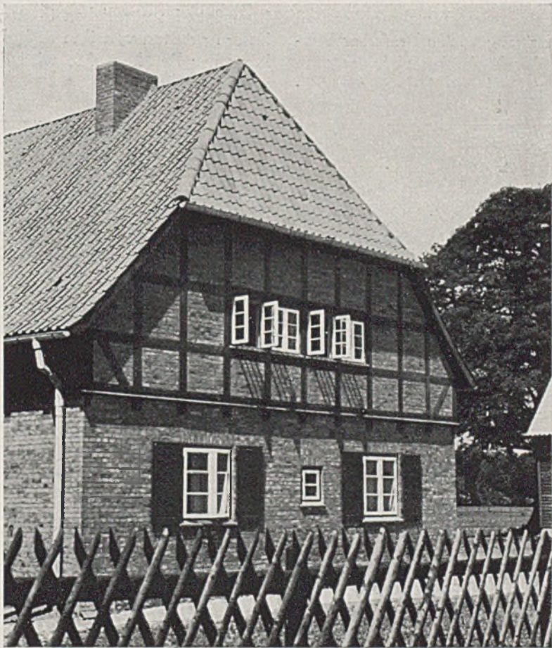
Ansicht der Giebelseite mit Krüppelwalm zum Typ 6 u. 6a für Mecklenburg
