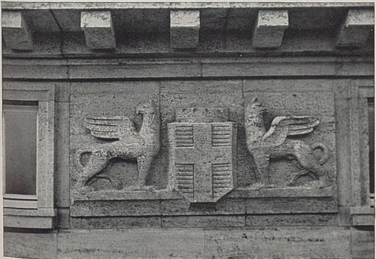
Einzelheiten der Steinarbeit am Gesims und Wappenfries des neuen Reichspostdirektionsgebäudes in Karlsruhe i. Baden
