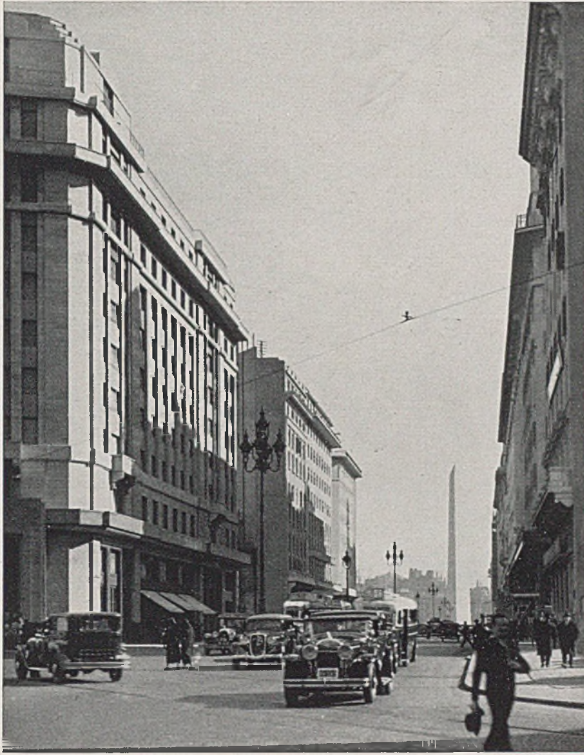
Buenos Aires, Blick aus der neuen „Diagonal-Norte“ auf den Obelisken. Die Gestaltung der Straßenzwände zeigt wohl Einheitlichkeit, aber wenig Leben. Unten Lageplan der 140 m breiten Avenida de 9 Julio mit Fußgängerunterführungen beiderseits des Obelisken und Autorampen
