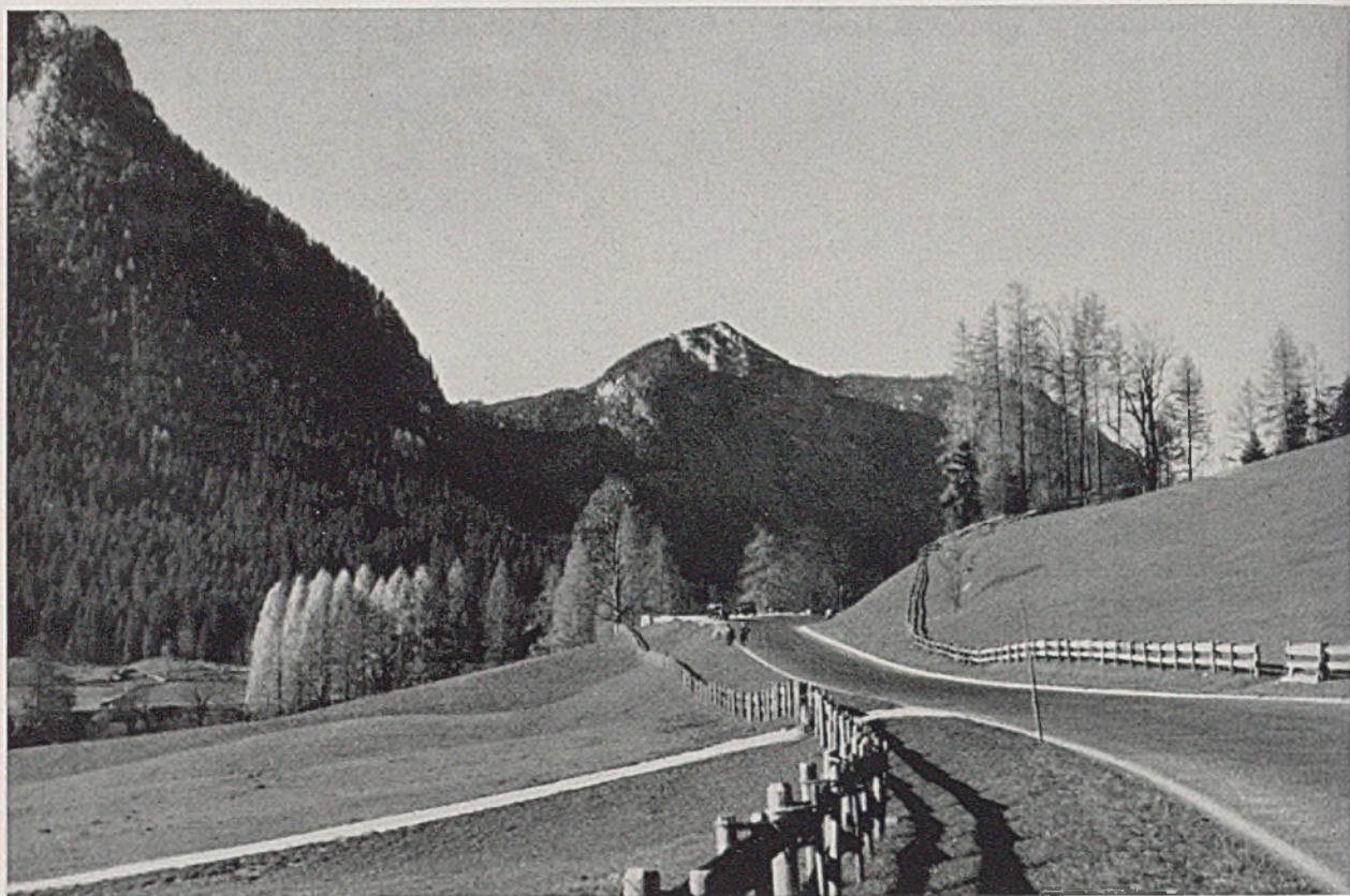
Deutsche Alpenstraße bei Berchtesgaden, Verbindung zwischen der Ramsau und dem Chiemgau. Gute Einbettung der Autobahn ins Gelände unter Verzicht auf jedwedes Mauerwerk. Gestaltung: Staatl. Neubauleitung der Dt. Alpenstraße
