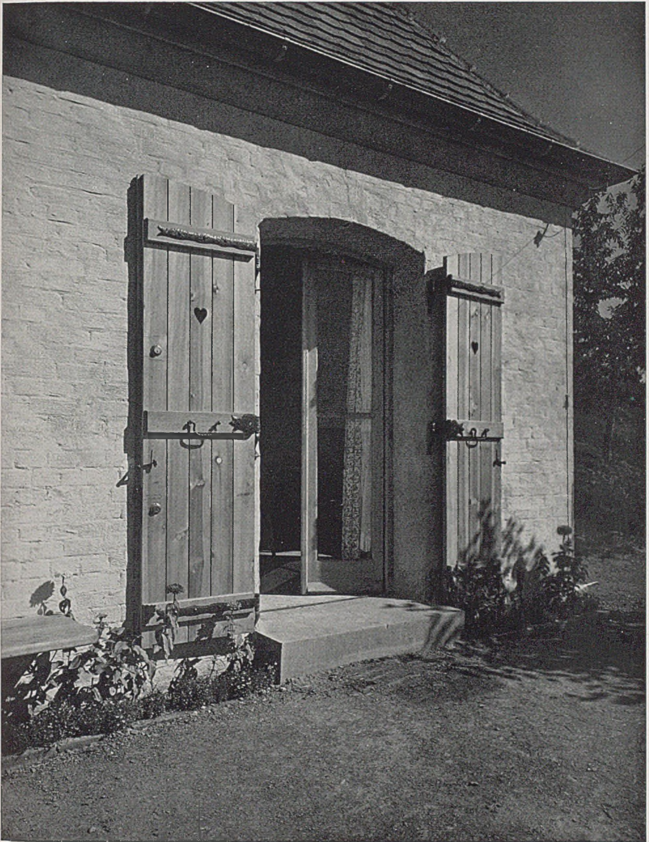
Eingang. Zweiflügelige Glastüre aus Forchenholz, Läden ebenfalls aus Forchenholz mit handgeschmiedeten Beschlägen
