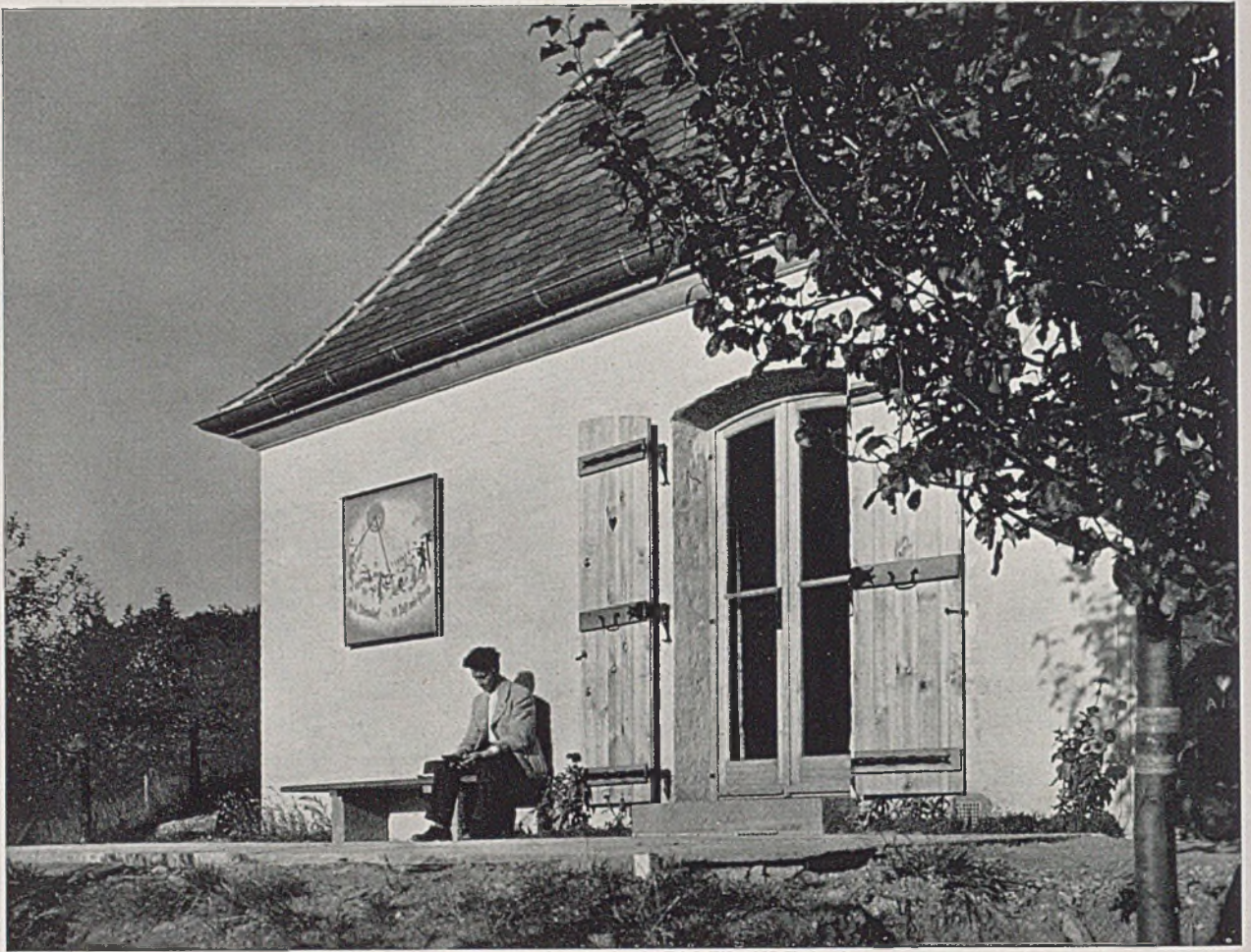
Frontansicht: Außenputz Weißkalkschlämme, Dächgesims aus Forchenholz profiliert, Sonnenuhr nach Entwurf von Kunstmaler Breiiling-Stuttgart. Hausbank, Füße roter Buntsandstein (Alle Fotos: Ohler-Stuttgart-S)
