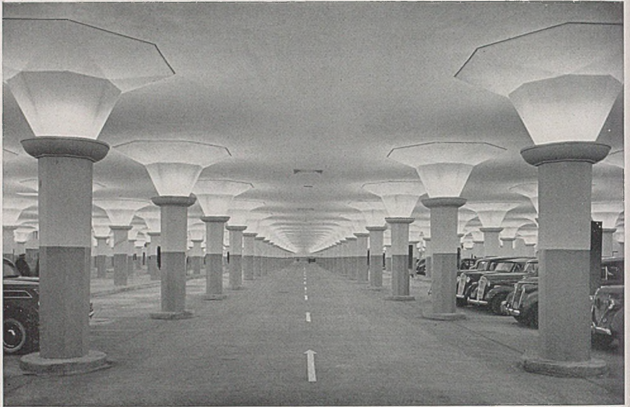
Mittlere Fahrstraße der unterirdischen Tages-Abstellanlage mit Pilzdeckenkonstruktion und indirekter Beleuchtung. Unten: Grundriß des südlichen Teiles im Maßstab 1:1500
