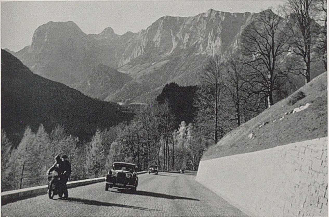
Abstieg der Deutschen Alpenstraße von der Schwarzbachwacht in die Ramsau mit niederer Talmauerbrüstung und Futtermauer
