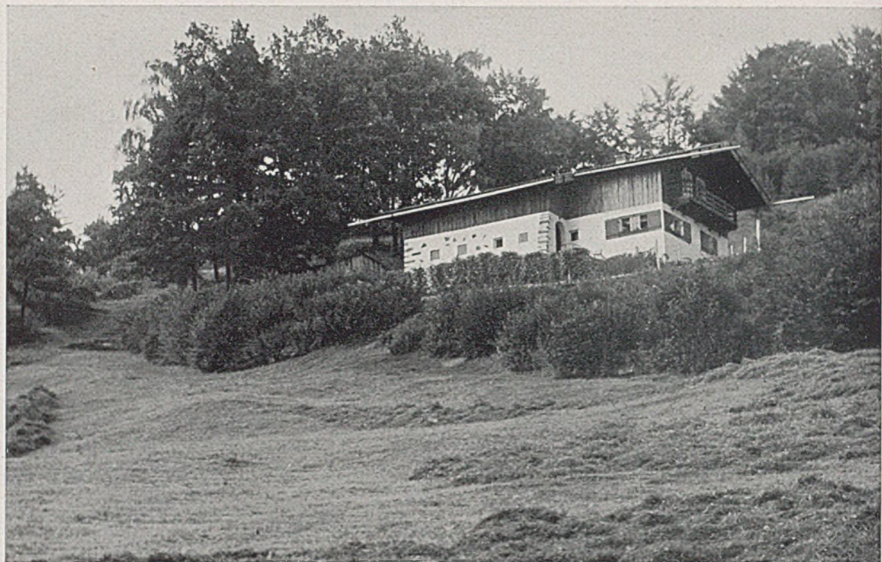
Anordnung Typ II parallel zum Hang in der Siedlung Petershäusl-Köppenreuth; unten Gruppensiedlung „Am Spicking“
