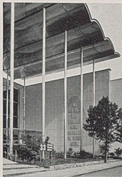
Halle „Aluminium“, verschiedene Ansichten der Eingangshalle. Stahlsäulen mit Aluminiumummantelung, Durchmesser 20,3 cm; Wasserbecken und Freiplastik von Bildhauer R. Wenning - Zürich (Foto oben rechts von L. Behringer-Zürich; übrige Fotos vom Verfasser)
