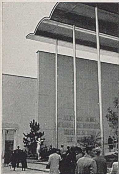
Halle „Aluminium“, verschiedene Ansichten der Eingangshalle. Stahlsäulen mit Aluminiumummantelung, Durchmesser 20,3 cm; Wasserbecken und Freiplastik von Bildhauer R. Wenning - Zürich (Foto oben rechts von L. Behringer-Zürich; übrige Fotos vom Verfasser)
