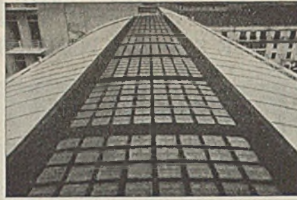
Von links nach rechts: Dachwalm mit Stützgeländer an einem Gebäudedeck, begehbarer Glasdachstreifen, Gratausbildung des gekrümmten Aluminiumdaches
