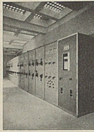
Ober- und Seitenlicht, Maschinenüberwachungs- und Hochspannungsraum unter Verwendung von Glasbausteinen
