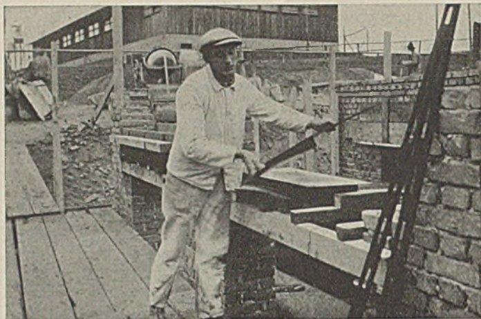
Das Anbringen der Schalung und der Schalungsunterlage und der sogenannten Metallschalung (Fotos Hans Joß - Bad Aibling)
