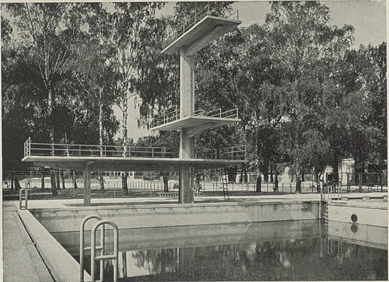
Schwimmstadion mit Sprungturm. Zwei Becken: 50 \times 18 m das Schwimmbecken, 33\frac{1}{3} \times 18 m das Sprungbecken. Unten Eingang zum Schwimmbecken
