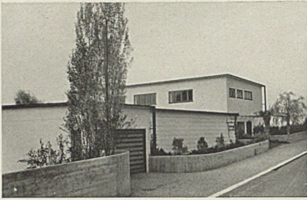
Haus Salvisberg. Blick von der Straße
