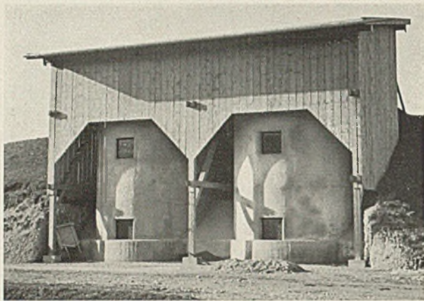
Armierter Ziegelsilo aus Nut- und Federsteinen
