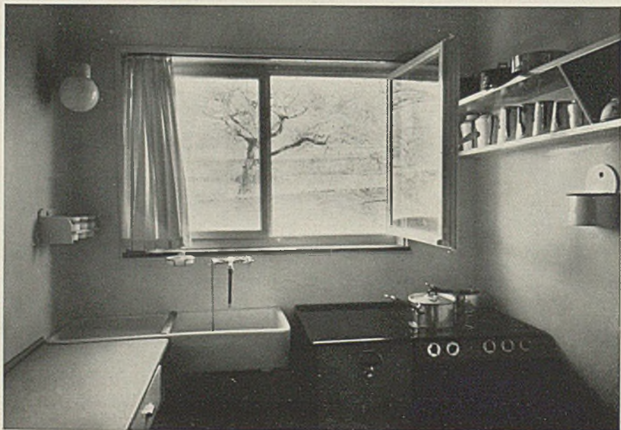
Blick zum Wohnraum mit festverglastem Kristallglasfenster (3,6×1,8 m) vom Eßraum aus. Unten Ansicht des Küchenfensters, unter diesem elektrischer Kochherd mit Bratofen. Wandanstrich Honsalin-Hartglasuranstrich (säure- und stoßfest, fugenlos).
