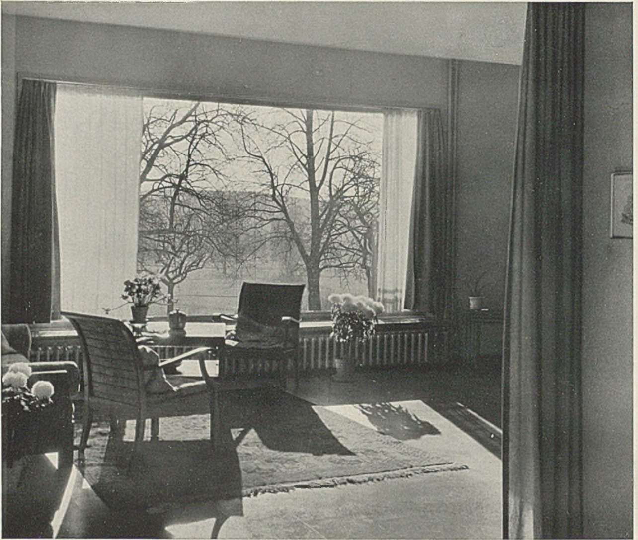
Blick zum Wohnraum mit festverglastem Kristallglasfenster (3,6×1,8 m) vom Eßraum aus. Unten Ansicht des Küchenfensters, unter diesem elektrischer Kochherd mit Bratofen. Wandanstrich Honsalin-Hartglasuranstrich (säure- und stoßfest, fugenlos).
