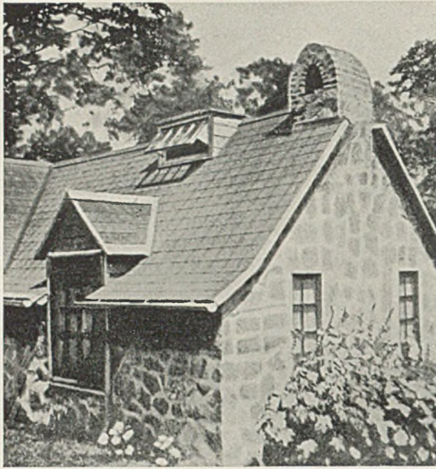
Teil eines Hauses auf Long Island, Arch. E. Flagg, das die Kennzeichen dieser Bauweise gut zeigt: Mauerwerk, niedrige Längswand, Dachdeckung und Firstgrube (Abb. 2)
