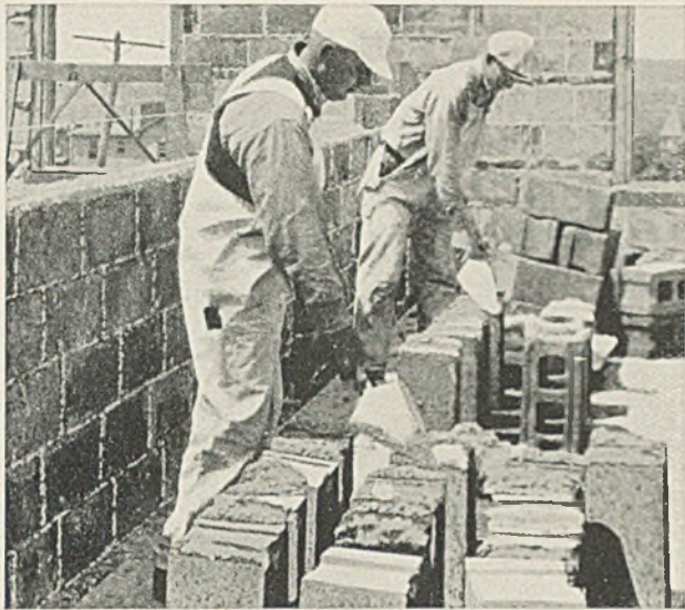
Schlackenholzziegelbau. Die ziemlich großen Steine werden reihenweise versetzt, nachdem der Mörtel vorher aufgetragen ist. (Abb. 7)
