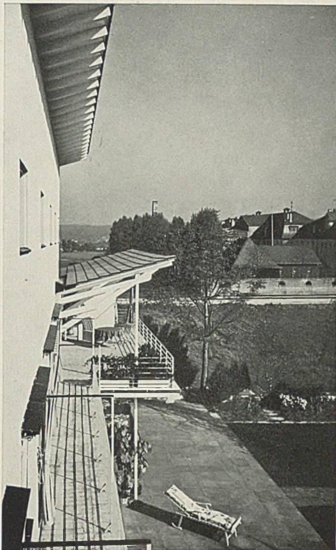
Blick entlang der Südfront
