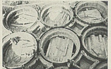
Die Zellenböden eingeschalt
