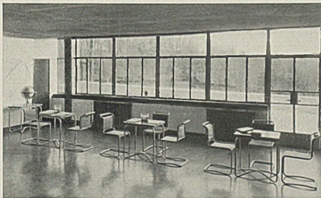
Typische Klasse mit durchgehenden Be- lichtungsstreifen ohne Fenstersturz
