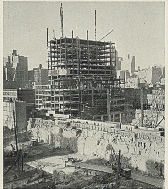
Das Rockefeller-Center im Bau Rechts Ausschachtung und Felsensprengung 3—4 Stock tief (Phot. W. H. Kilham jr.)
