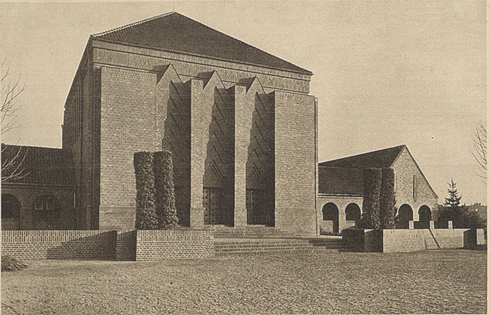
Hauptansicht mit Vorfahrtsrampe
