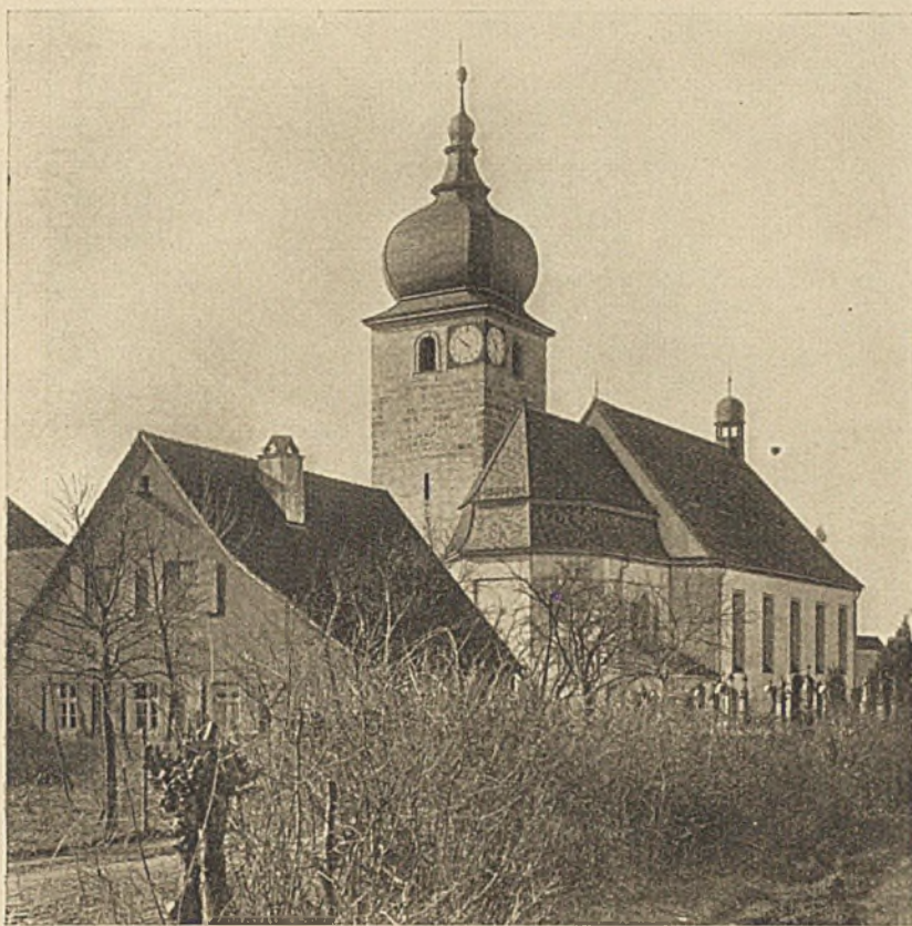
* Kath. Kirche zu Langensendelbach
