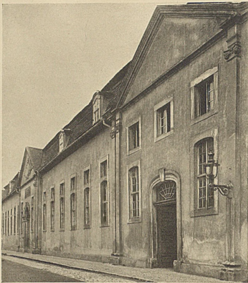
* Das Kreishaus II und Finanzamt in Bernburg Ansicht vor dem Umbau * Arch. Reg.- u. Baurat Dipl.-Ing. H. Wendler - Bernburg
