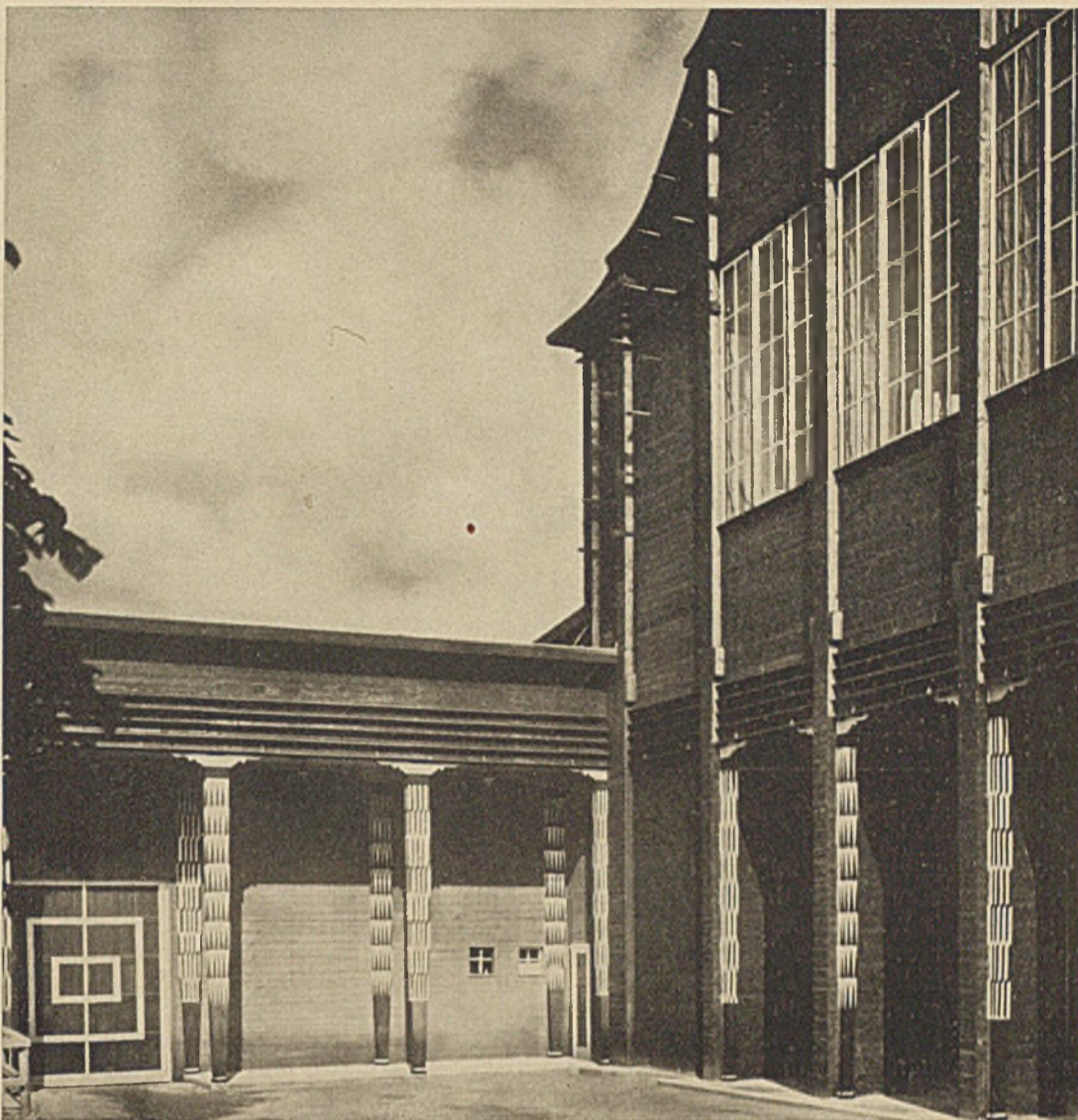
*Luftfahrthalle auf der D.V.-A. München — Teilansicht
