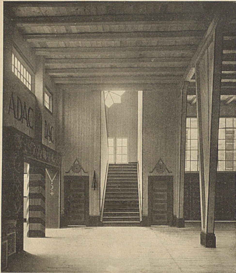
*Arch. B.D.A. Prof. O. O. Kurz - München *Kraftwagenhalle auf der D.V.-A. München — Vorraum
