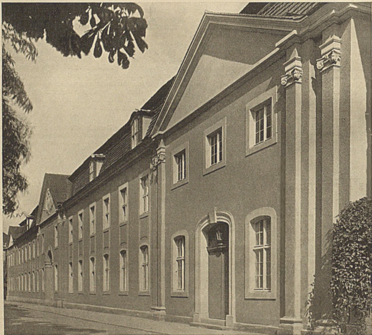
* Ansicht nach dem Umbau
