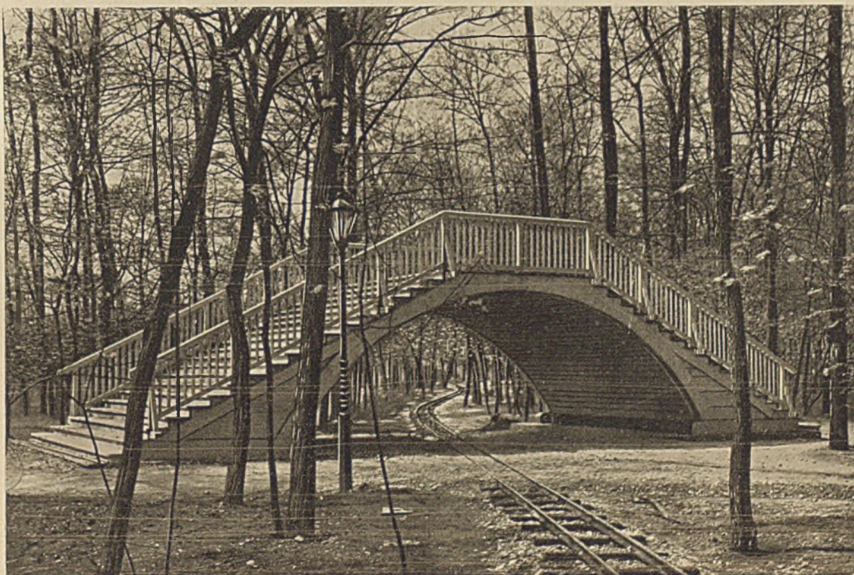
Ueberbrückung der Liliputbahn — *
