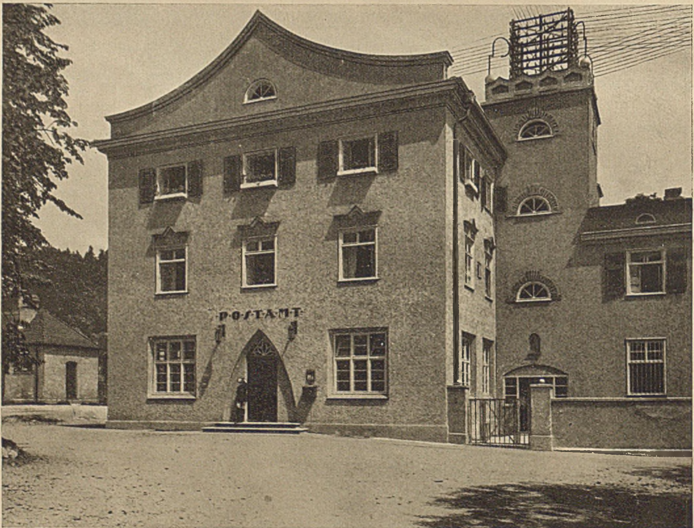
Postdienstgebäude in Wasserburg — Gesamt-Ansicht
