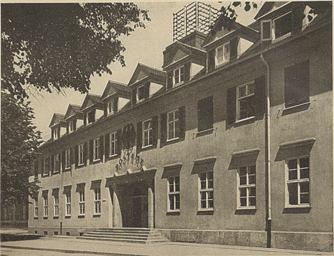
Postdienstgebäude in Nördlingen — Straßen-Ansicht
