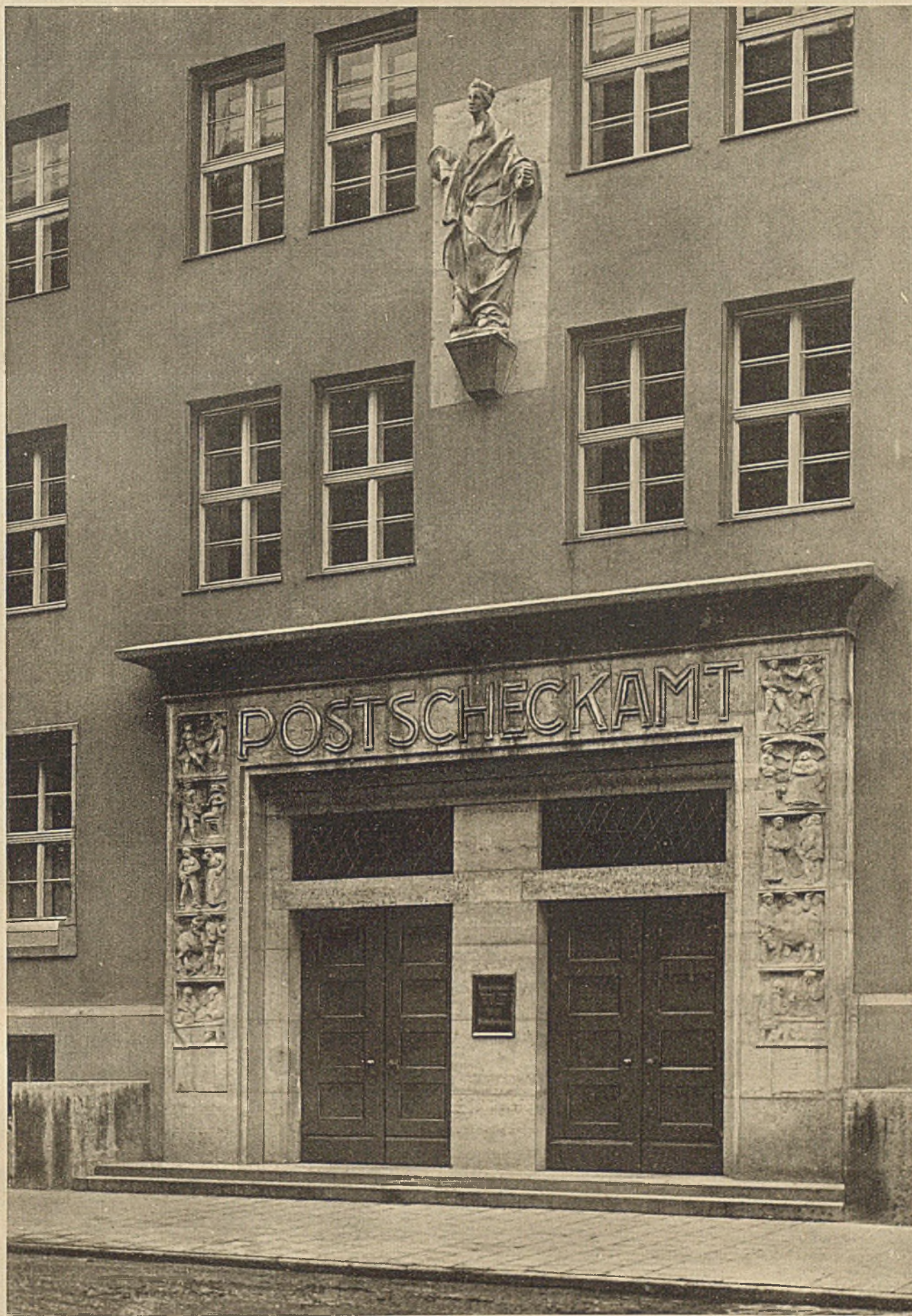
Postcheckamt Nürnberg — Haupteingang
