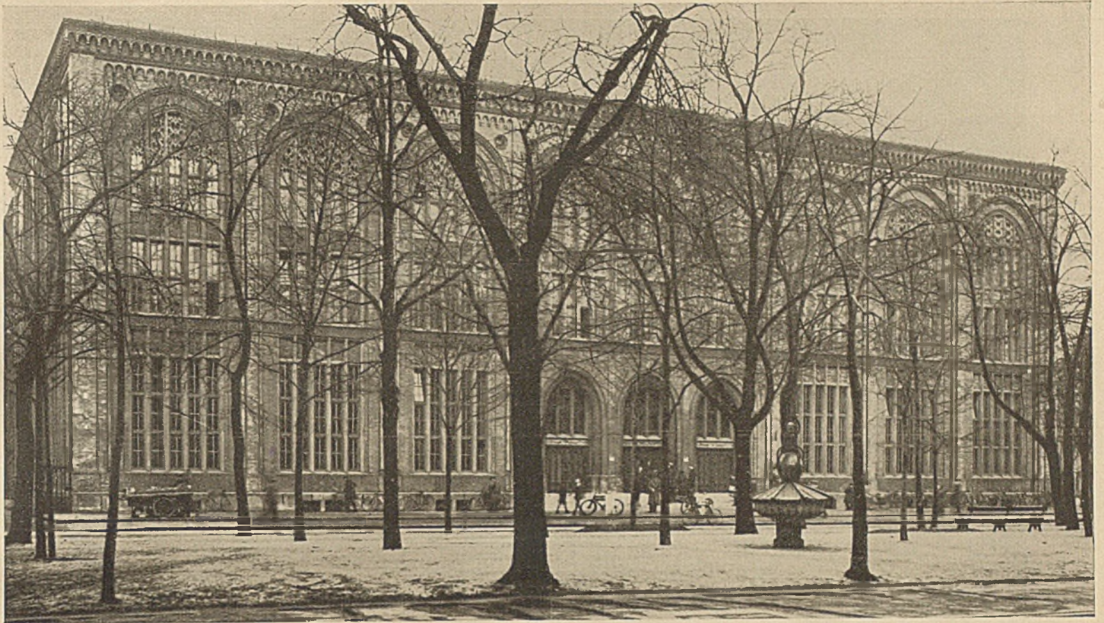
• Postscheckamt München — Haupt-Ansicht
