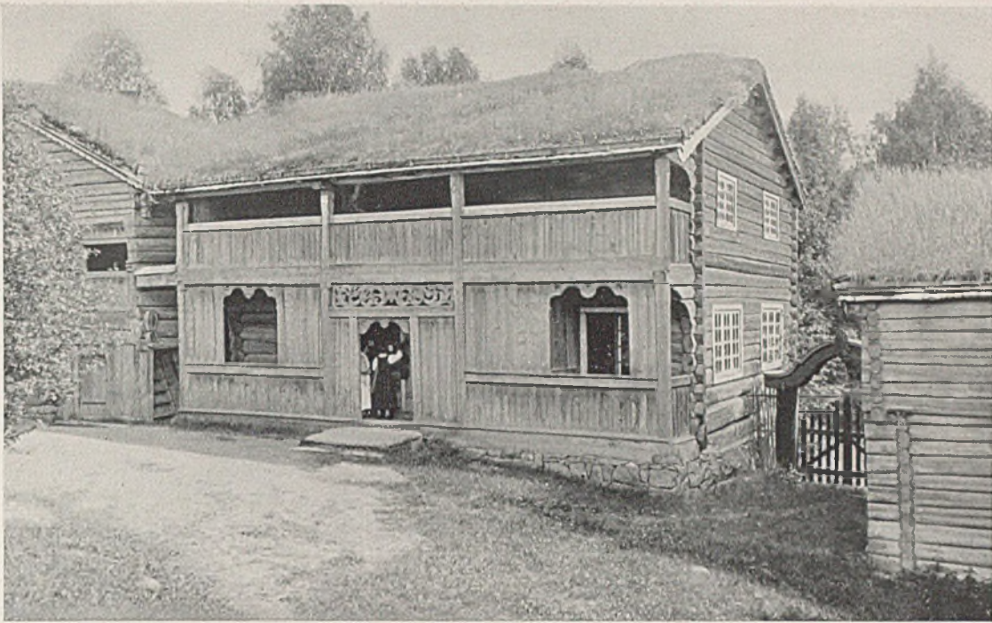
Bild 13. Zweigeschossiges Wohnhaus auf dem Hof Bjölsstad, um 1787 (*)
