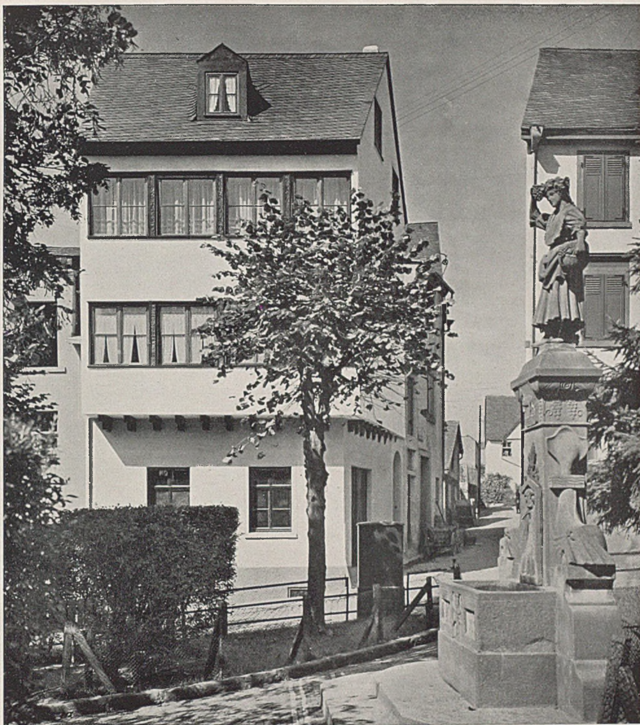
Haus C. in Traben-Trarbach a. d. Mosel. Arch. Ernst Gondrom
