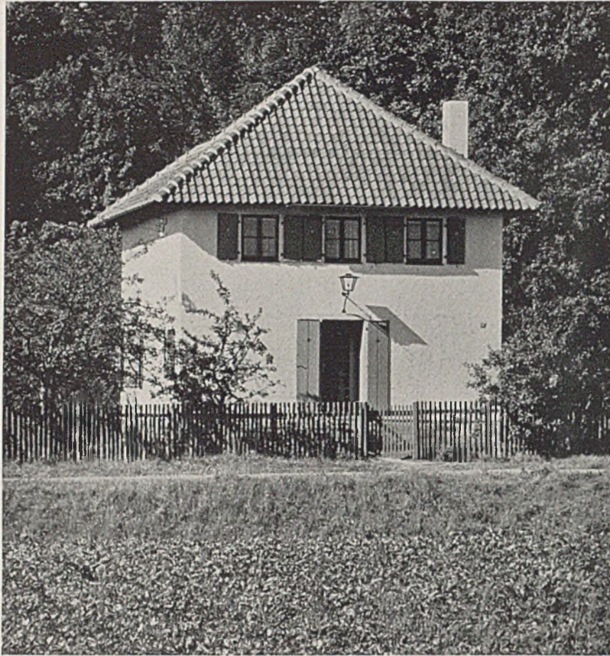
Eingangsseite des Eigenheims Nolte
