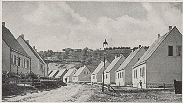
Kleinsiedlung Würzburg. Straßenseite
