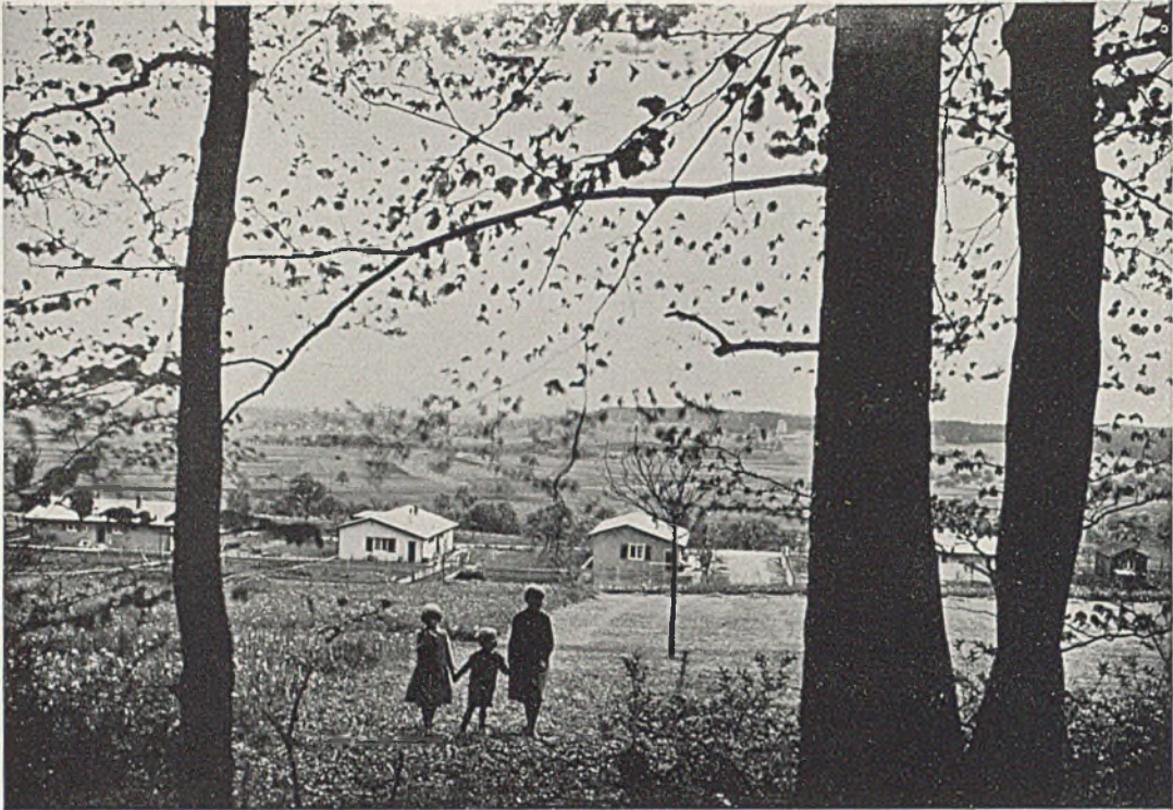
Siedlung Schatzacker, Bassersdorf bei Zürich. Blick vom Waldrand auf die Siedlung
