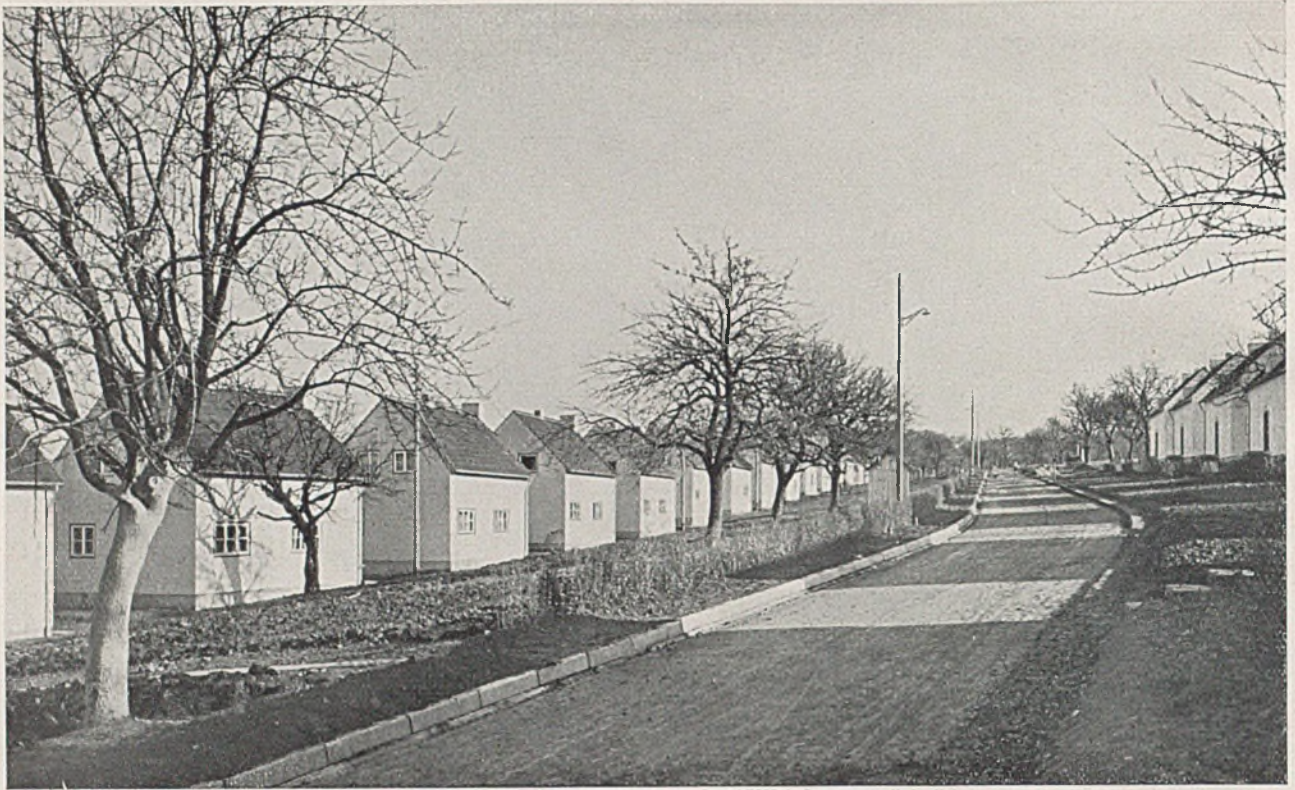
Siedlung Weil im Dorf-Reissachgelände bei Stuttgart. Ansicht der Straße 3
