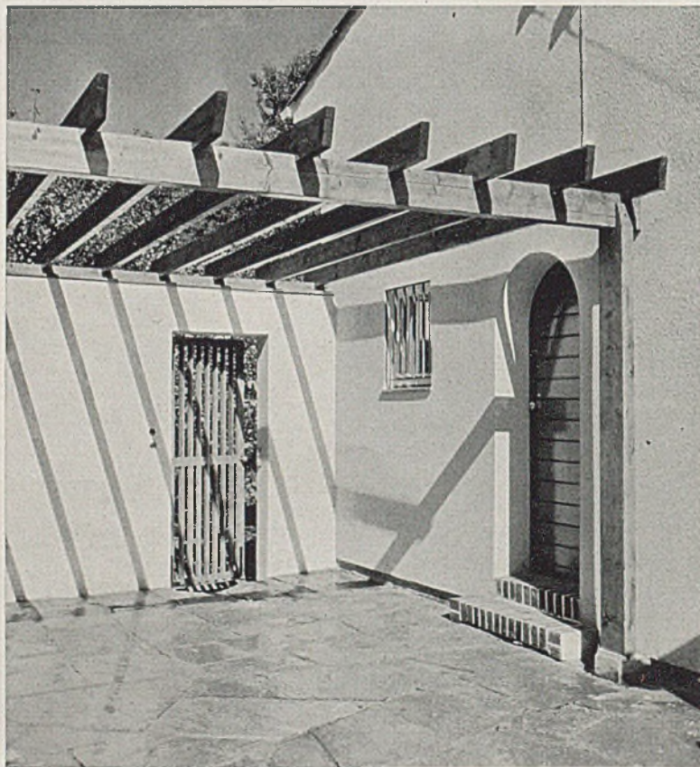
Ein größeres Wohnhaus bei Stuttgart
