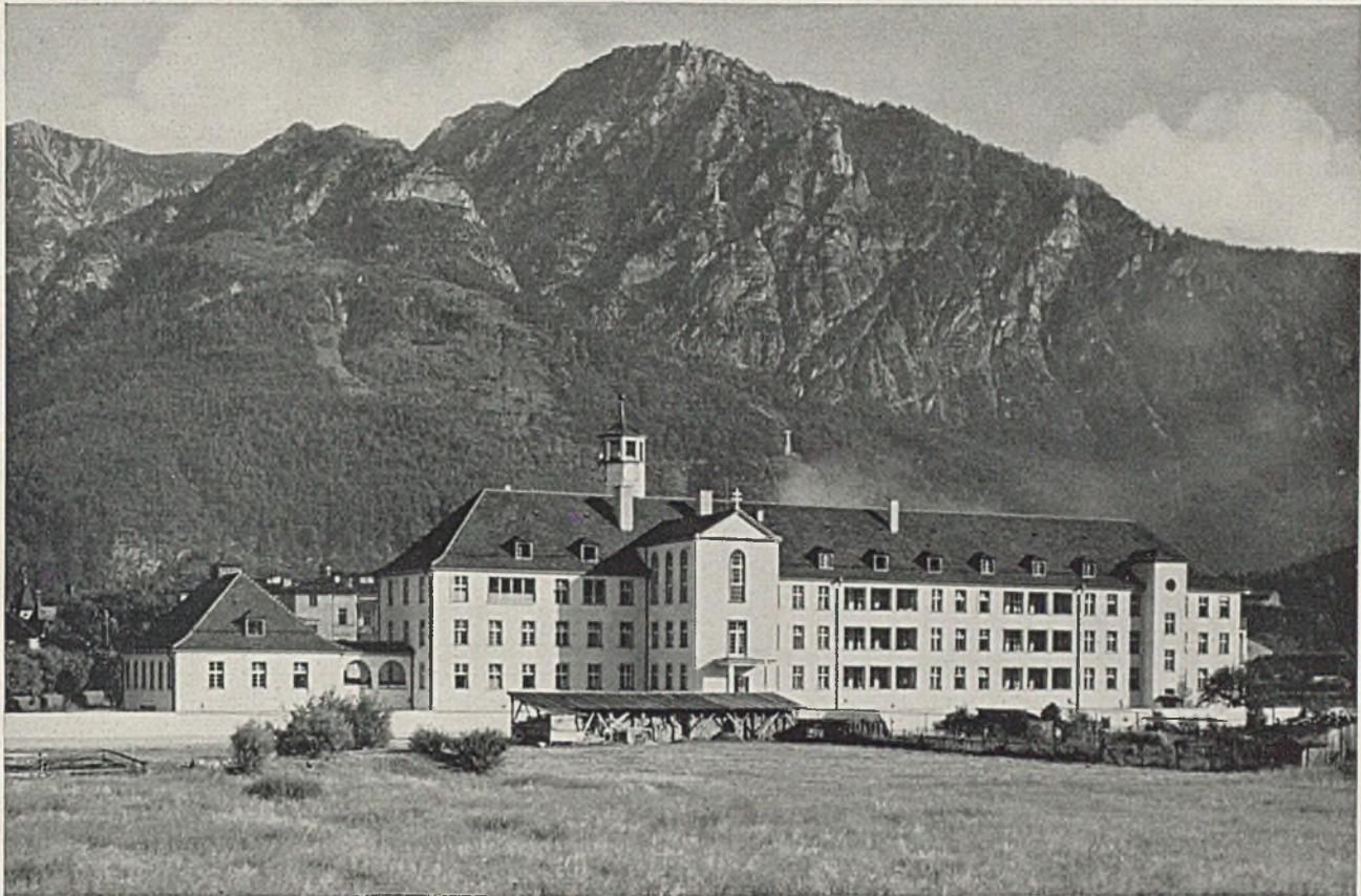
DAS STÄDTISCHE KRANKENHAUS IN BAD REICHENHALL. Erbaut 1928-29. Architekt Prof. Dr. R. Schachner, München
