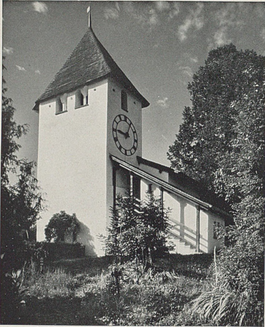
Kirche in Riggisberg Architekten Dubach und Gloor Ansicht von Nordosten
