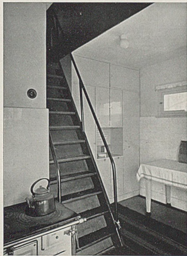
Blick in die Küche. Die Stiege ist in heruntergeklapptem Zustand (betriebsfähig)
