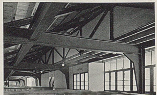
Innenansichten der Hanseatenhalle Hamburg. Verschiedene Platzverteilung (Konstruktionsprinzip)
