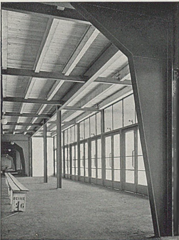
Einheit des Stützen- und Konstruktionssystems im Inneren und Äußeren
