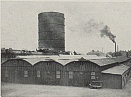
Die alte Lagerhalle von außen
