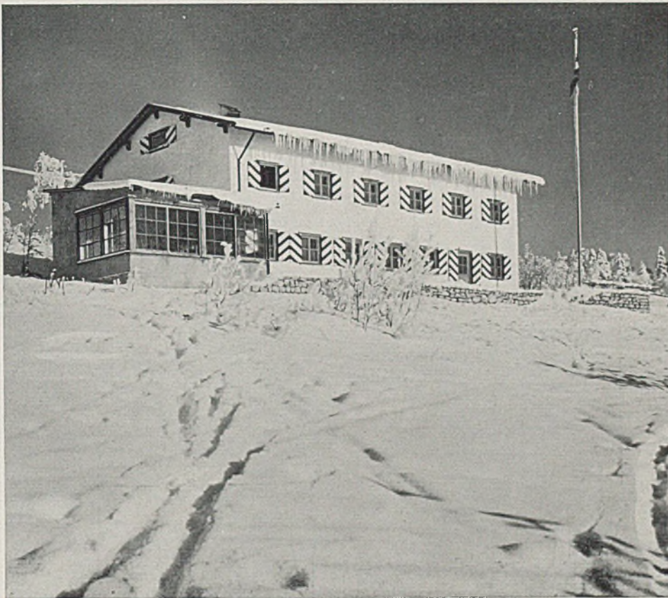
Berghaus Mont Moron. Alles Holzwerk am Äußeren ist lasiert und geölt, die Läden sind in Ölfarbe gestrichen. Das Fachwerk ist außen mit 3 cm starken Dämmplatten verkleidet, darüber 3 Lagen Putz, geweißelt.
