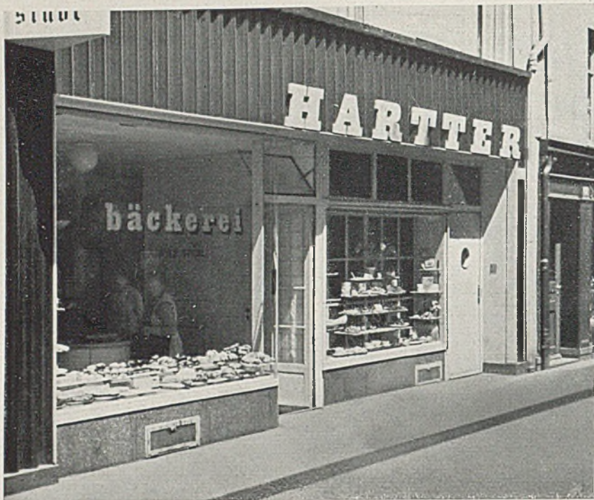
Der Ladenumbau von der Straße aus gesehen (hierzu siehe Tafel 31)
