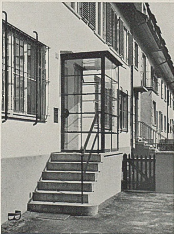
Wohnhaus mit Malerwerkstatt
