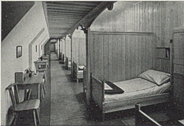
Schlafräum im Dachgeschoß der alten Rentei
