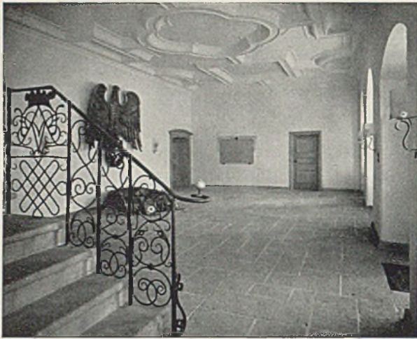
Eingangshalle mit altem Treppengeländer
