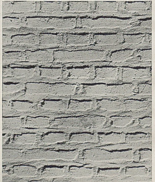
Oberflächenbehandlung der Außenwand
