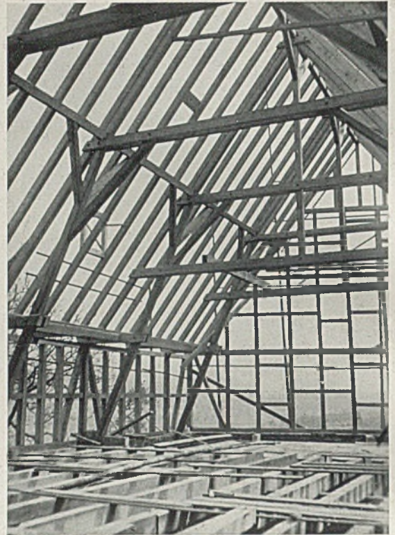
Gutshof „Schwärzloch“. Links oben: Hof mit Scheune und Hühnerauslauf. Darunter: Die Hocheinfahrten (von Süden) Rechts: Dachstuhl über den Stallungen nach dem Aufschlagen
