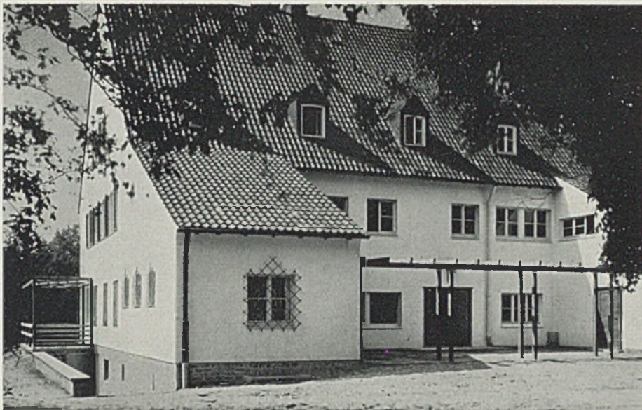
Hauseingang im Wirtschaftshof an der Nordseite
