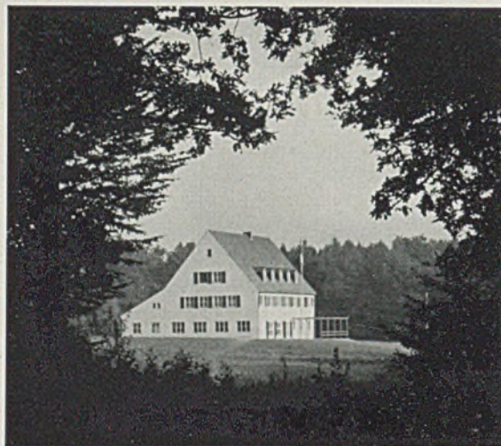
Blick von Südwesten auf die Herberge
