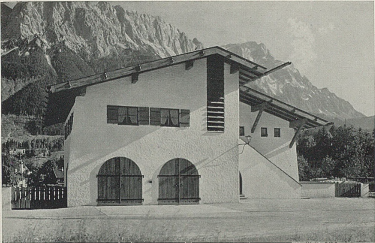
Feuerhaus Grainau. Die rechte Hausecke ist zurückgenommen, um eine hohe Ecke als Schlauchrockenturm auszubilden
