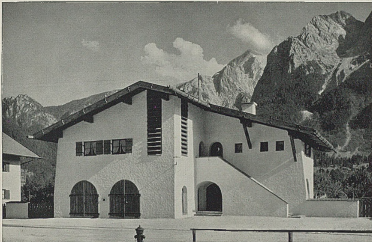
Feuerhaus Grainau am Fuße der Zugspitze; Ansicht von der Straßenseite mit Toreinfahrten
