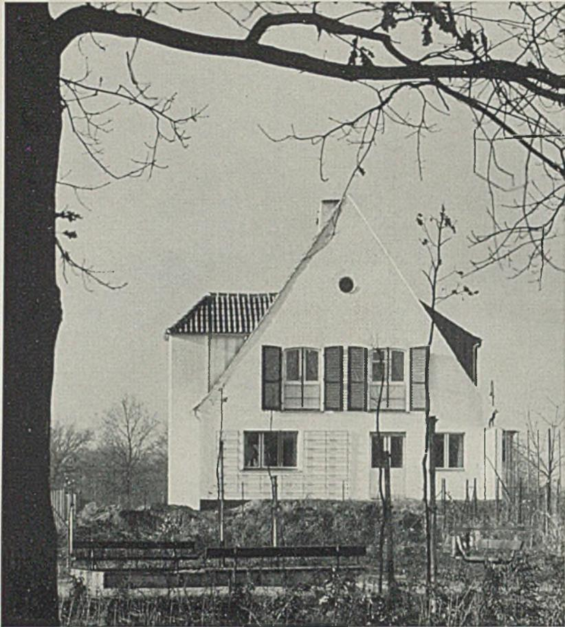
Im Mittelteil (dort wo sich Dachausbauten befinden) sind die Mittelpfetten verdoppelt und über den aufgehängten Kehlbacken angeordnet worden, so daß sie in den Räumen nirgends in Erscheinung treten. Die Außenwände sind ein Stein stark in Blockverband gemauert und mit 3 cm starken Isolierplatten verkleidet und geputzt, außen gefugt und ge-
