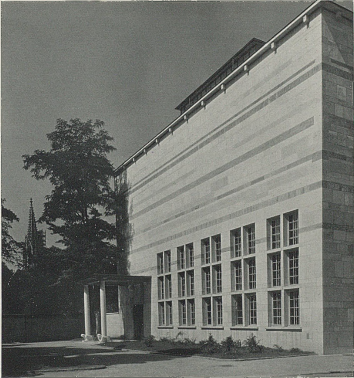
Ansicht vom Dufourplatz; Eingang zum Vortragssaal mit Vordach
