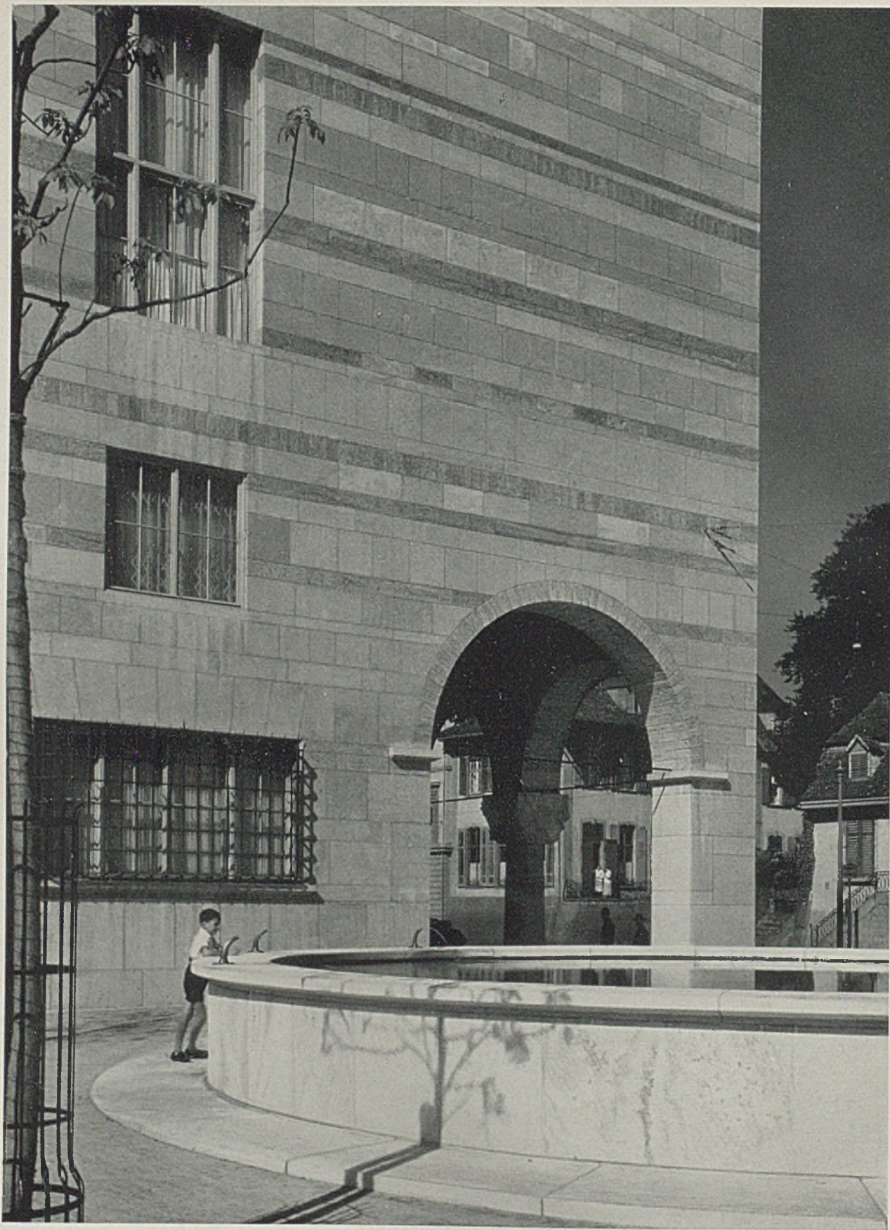
Wanddetail Ecke Dufourstraße und Albangraben. Im Vordergrund Brunnentrog aus Castione-Granit
