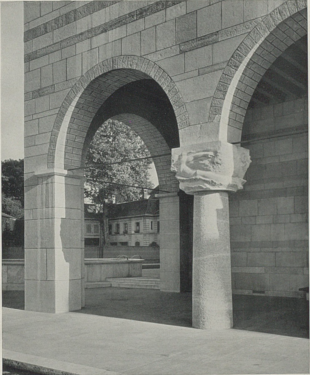
Hauptfassade, Ecke Albgraben-Dufourstraße
