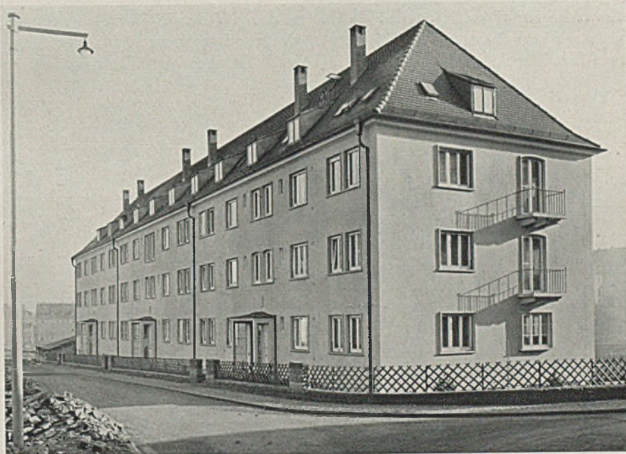
Die Bauanlage der Bahn- und Poststerbekasse von der Straße aus gesehen
