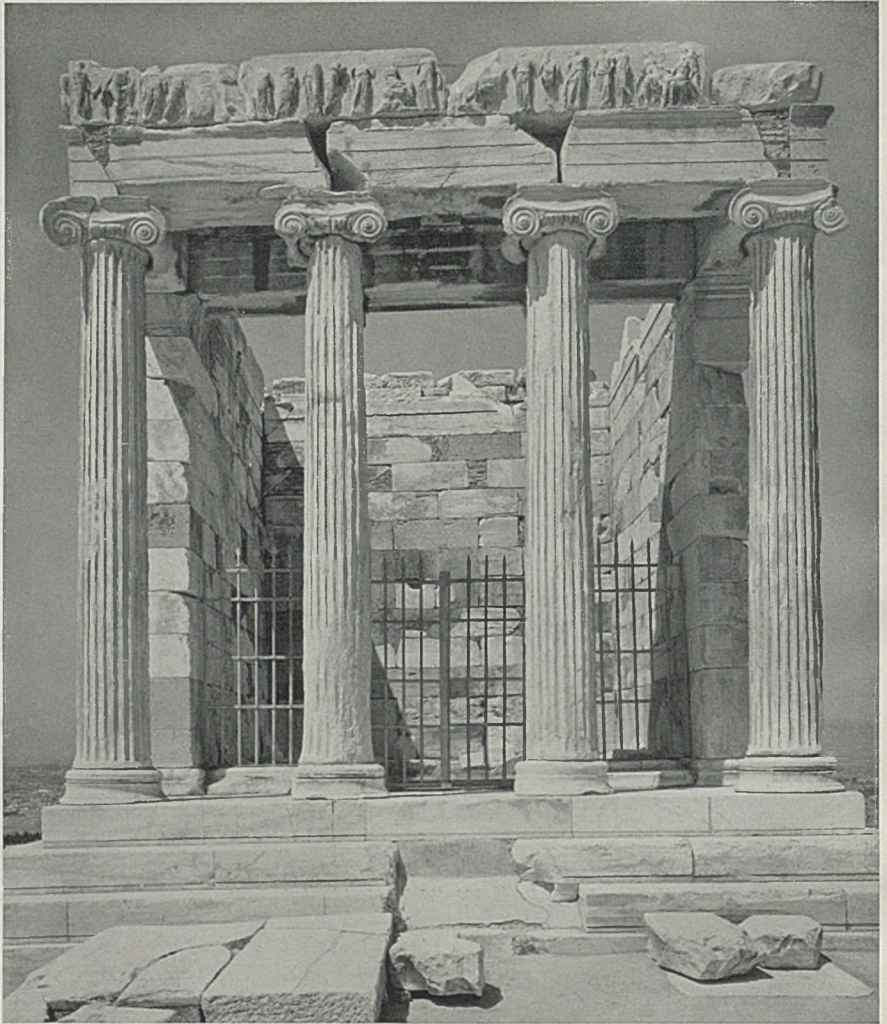
Tempel der Athena-Nike von Osten. Einblick in die Cella. Freistehender Amphiprostylos Entwurf des Architekten Kallikrates, begonnen 448 auf Grund eines Volksbeschlusses. Fortführung des Bauwerks nach dem Frieden des Nikias (421). Beendigung erst 405. Kleinster Bau der Akropolis „Die volle Schönheit einer griechischen Fassade enthüllt sich ungetrübt nur in der strengen Vorderansicht.“
